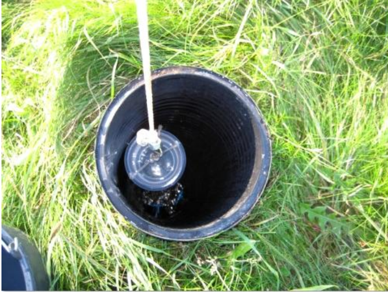
Kuva 1. Jäteveden nostamista kokoomakaivosta kohteella 8
