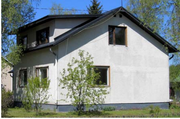
Kuva 6. Raskaat kattolyhtyrakennelmat eivät sovi rintamiestaloon
