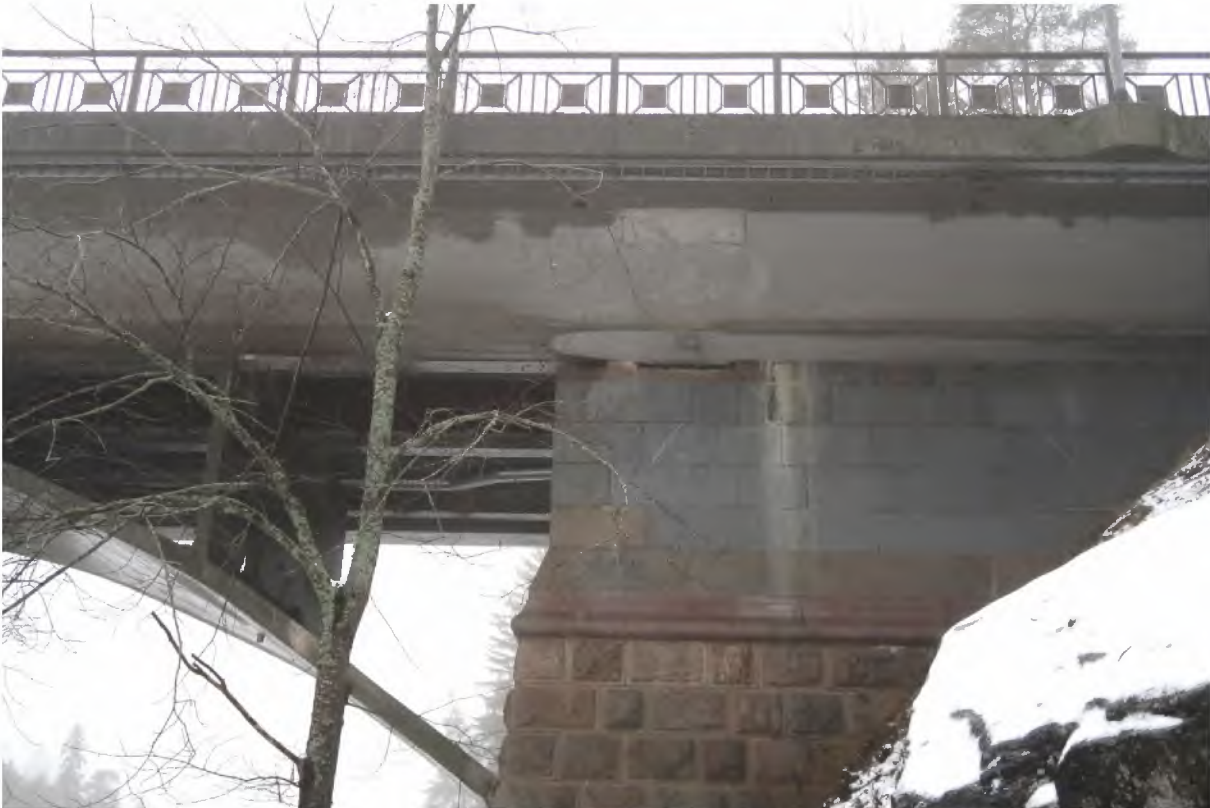
Kuva 39. Maatukien yläosien kivityö vaikuttaa uudemmalta kuin alaosien ja kivet ovat harmaita, kun vanhat kivet alaosassa ja koristelistassa sekä sen yläpuolella ovat hieman punertavaa kiveä. Tämä viittaa siihen, että maatukien yläosat olisi joskus uusittu.
