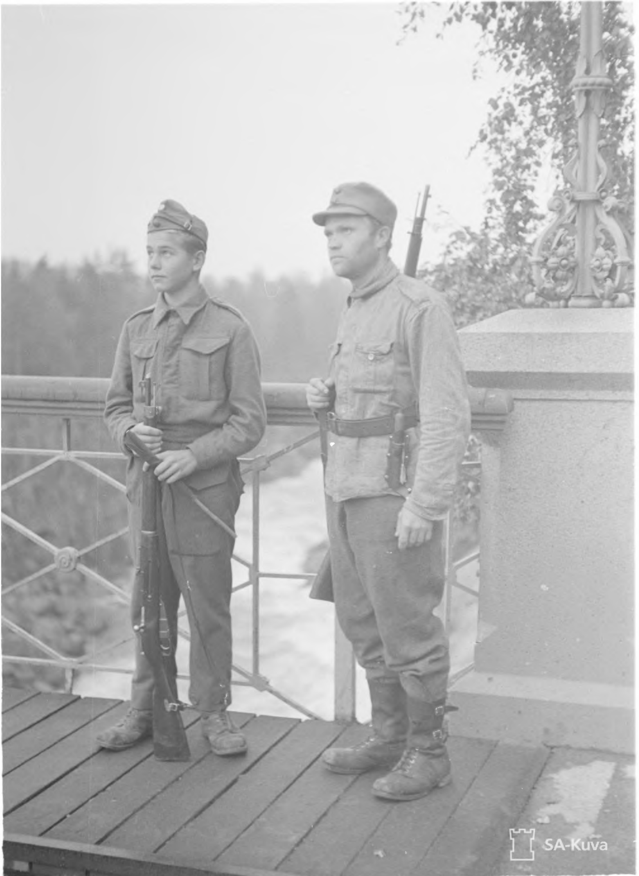
Kuva 13. Sillan alkuperäiset kaiteet detaijeineen ja puurakenteisen kannen jalankulkuväylä hyvin kuvassa, samoin kuin valaisimen jalka. Kuvassa Tenho Miikki ja Aaro Ruusu vahtimassa siltaa vuonna 1941. Kuvaaaja K. Sjöblom, Sotamuseon arkisto. CC BY 4.0
