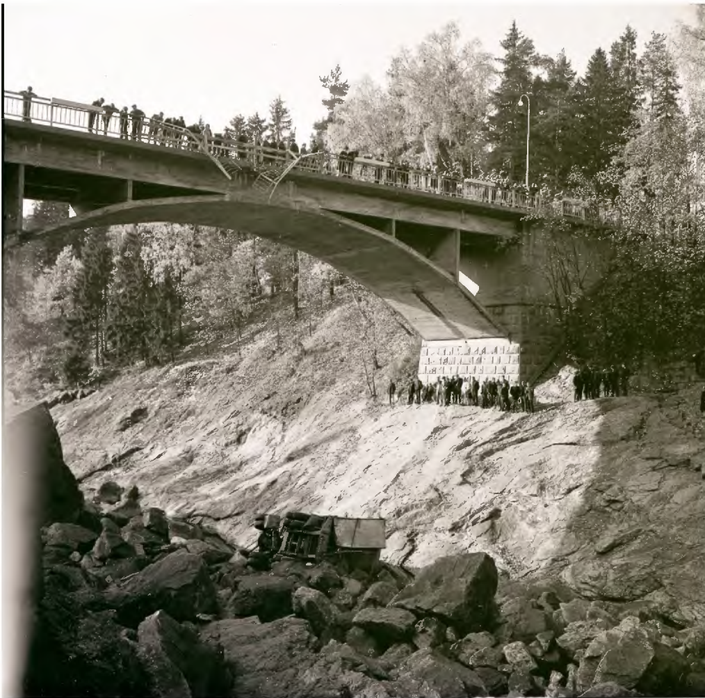
Kuva 19. Onnettomuus vuonna 1964. Rekka-auto on pudonnut Imatrankoskeen ja kaide on rikkoutunut. Kuvaaja Kosken Kuvaamo, Lappeenrannan museon kuva-arkisto.
