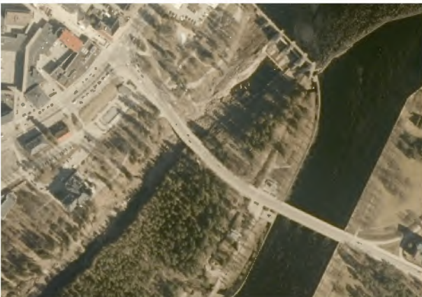
Kuva 7. Koskisilta ja Kanavasilta vuonna 2014, kun niitä on levennety 1970-luvulla reunoille lisätyillä uusilla kevyen liikenteen väylillä. Maanmittauslaitoksen vanhat ilmakuvat.
