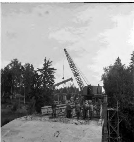
Kuva 17. Yllä on kuvasarja uuden sillan rakentamisesta vanhaa siltaa tukena käyttäen 1950. Kuvaaja on Valokuvaamo Kuvapaja ja kuvat on saatu Imatran kaupunginmuseon kuva-arkistosta.
