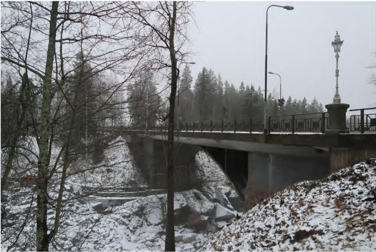
Kuva 38. Kevyen liikenteen väylät ulottuvat maatukienkin ulkopuolelle. Sivusta katsottuna kevyen liikenteen väylän rakenteen vuoksi sillan kaari jää taka-alalle ja silta näyttää suoralta.
