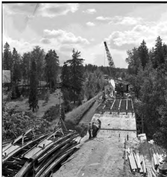
Kuva 17. Yllä on kuvasarja uuden sillan rakentamisesta vanhaa siltaa tukena käyttäen 1950. Kuvaaja on Valokuvaamo Kuvapaja ja kuvat on saatu Imatran kaupunginmuseon kuva-arkistosta.
