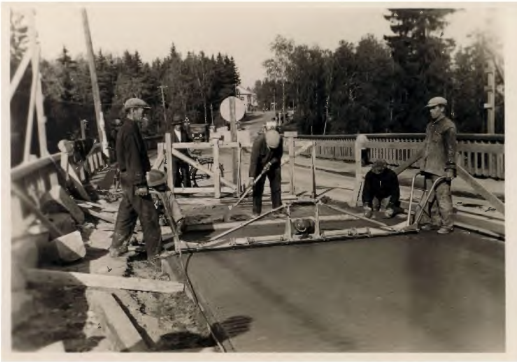
Kuva 18. Uuden sillan kannen päällystystä. Paul Jyllinvuoren kokoelma, Imatran kaupunginmuseon kuva-arkisto.
