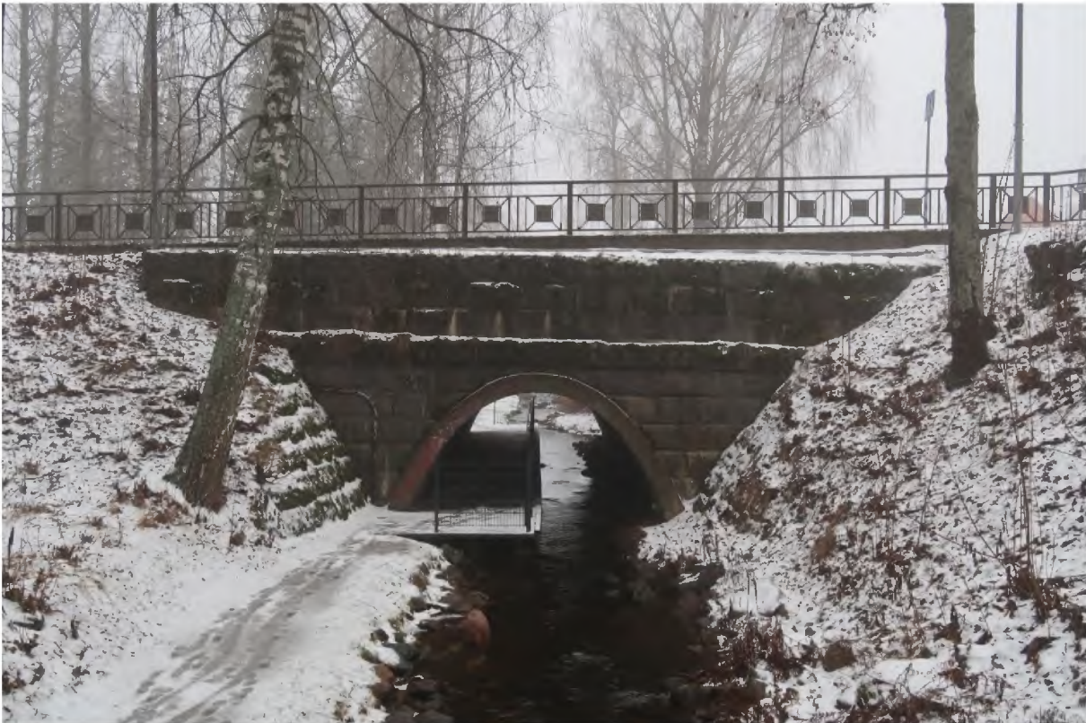
Kuva 45. Siltojen välisessä puistikossa on pieni silta uittorännin eli nykyisen kaupunkipuron ylitse. Silta ja ränni ovat todennäköisesti 1920-luvulta, vaiheesta, jolloin voimalaitos, pato ja kanava siltoineen rakennettiin. Betonikaari on todennäköisesti lisätty siltaan 1970-luvun siltakorjausten yhteydessä.
