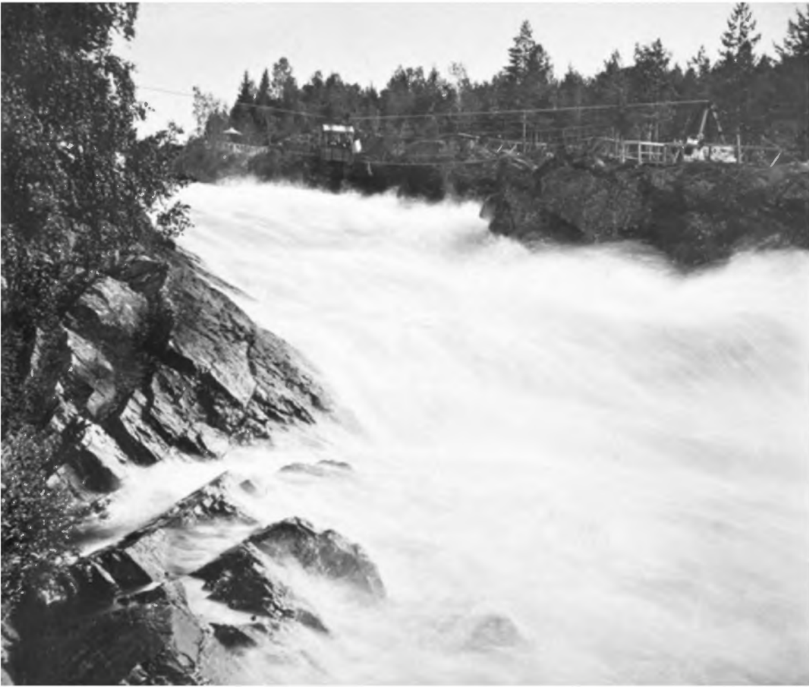
Kuva 3. Köysirata toiminnassa. Kori on ensimmäinen, katettu malli. Kuva Museovirasto historian kuvakokoelmat. Kuvaaja M. Seifert 1872–1881. CC BY 4.0.
