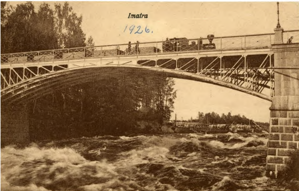
Kuva 12. Kun voimalaitosta ja uutta kanavaa rakennettiin 1922–1929, oli Imatran asemalta vedetty pistoraide työmaalle. Kuva on todennäköisesti tuolta ajalta ja sen perusteella pistoraide oli johdettu myös Koskisillan yli. Kuva Rautatiemuseo.
