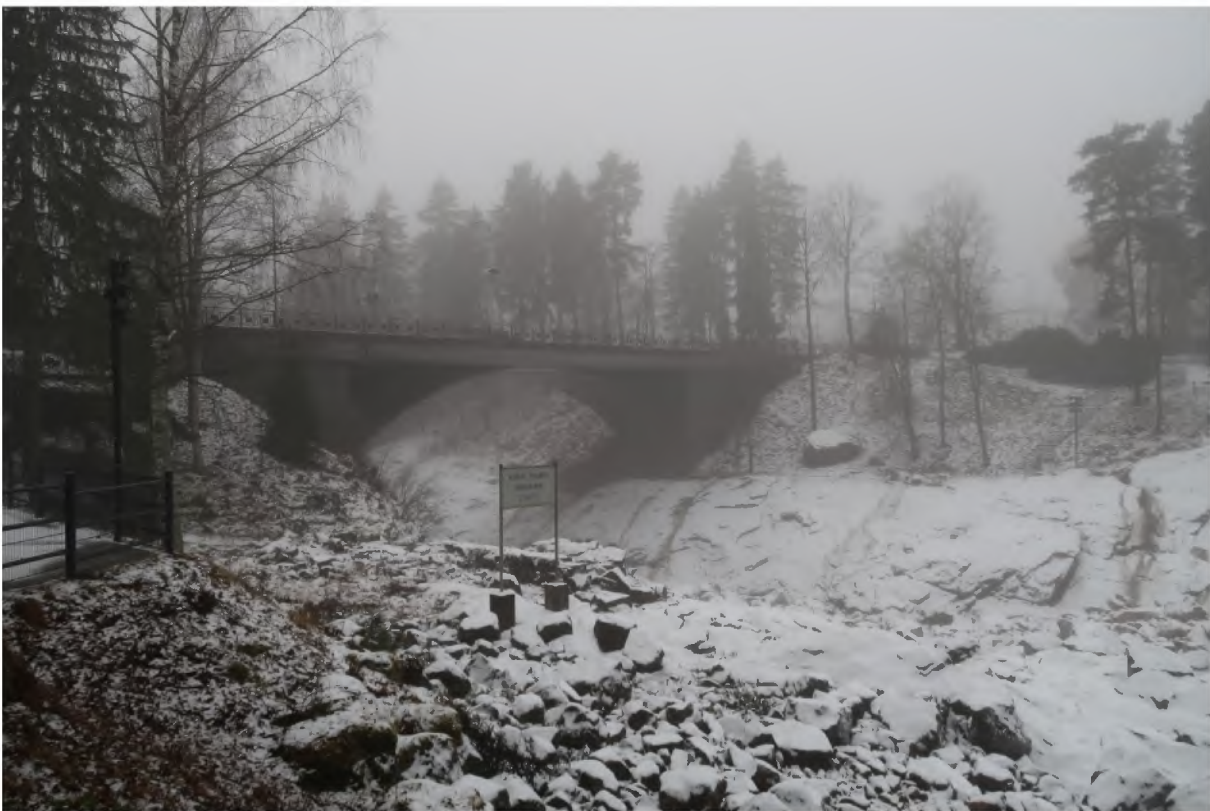
Kuva 35. Koskisilta itärannalta katsottuna kohti etelää. Sillasta hahmottuu erityisesti sen kaariholti.
