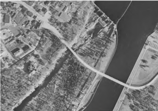
Kuva 6. Ilmakuva 1948. Kanava- ja Koskisillat olivat maisemassa hyvin siroja ennen kuin niitä levennettiin 1970-luvulla. Maanmittauslaitoksen vanhat ilmakuvat.
