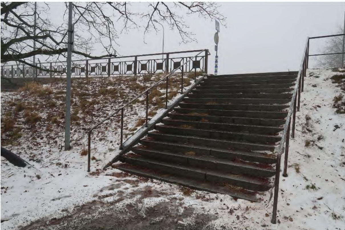
Kuva 30. Sillan itäpäässä on molemmin puolin graniittiportaat. Niiden kaiteet ovat yksinkertaisemmat kuin sillalla.
