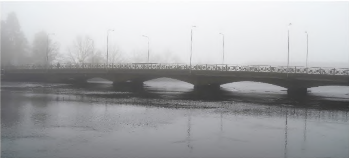
Kuva 32. Mitä kauempaa siltaa katsoo, sen paremmin sen alkuperäinen siluetti erottuu.
