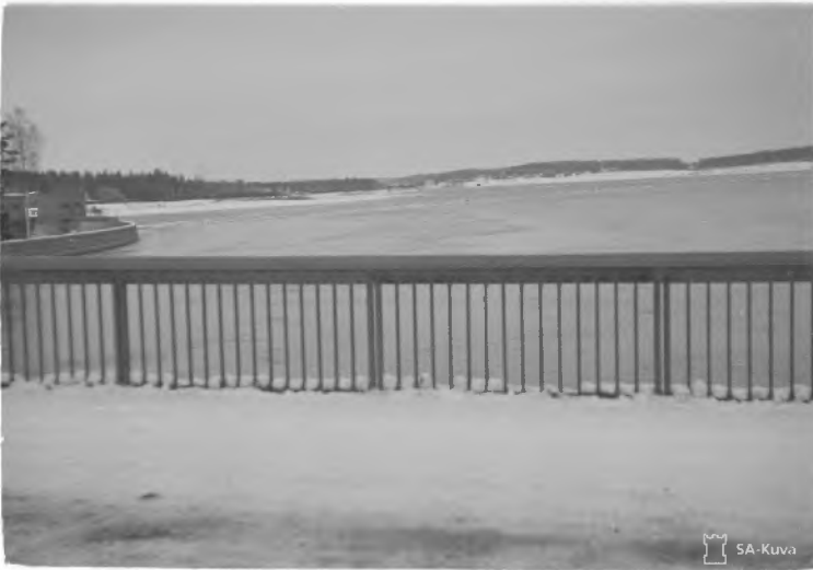
Kuva 16. Sillan alkuperäinen kaidemalli oli levollinen pystypinnakaide. Kuvaaja everstiluutnantti J. B. Jauhiainen, Sotamuseo. CC BY 4.0.
