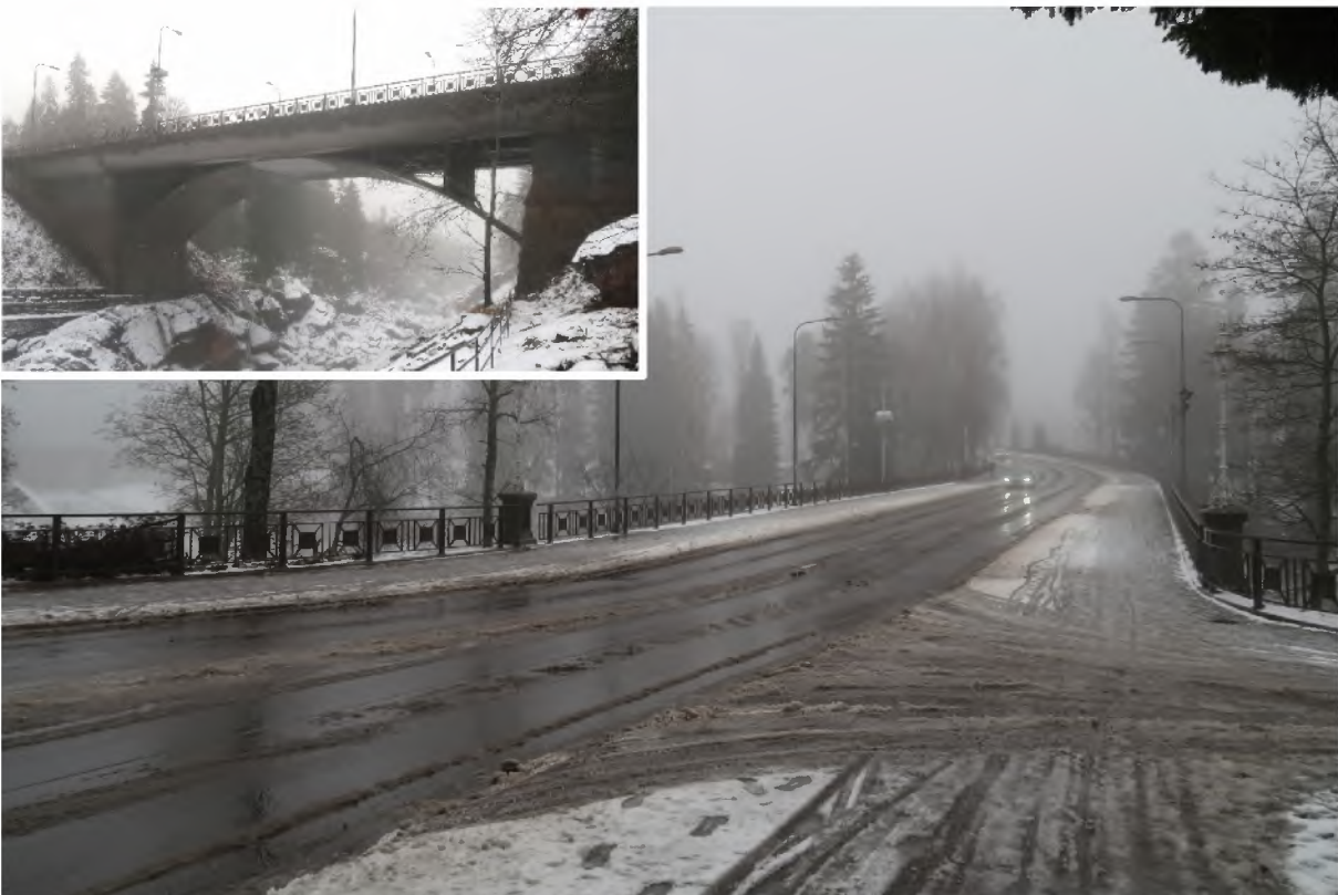
Kuva 28. Vertailuna näkymä viereiseltä Koskisillalta, joka on alun perin rakennettu vuonna 1892, mutta uusittu teräsbetonirakenteisena holvisiltana vuonna 1950. Näkymät sillan päällä on hyvin samankaltaiset, mutta kaukomaisemassa sillat tunnistaa profiilista.
