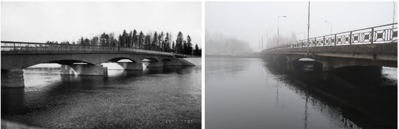
Kuva 24. Kanavasilta 1960-luvulla ja vuonna 2025. Vasen kuva Mobilia, kuvaaja Foto Roos.
