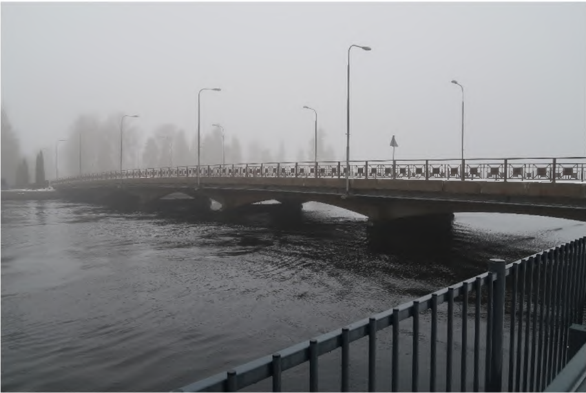
Kuva 31. Kauempaa katsoen sillan profiili kaarineen alkaa erottua. Etualalla kanavan reunaan asennettu pystypinnakaide, joka muistuttaa Kanavasillan alkuperäistä kaidetyyppiä.
