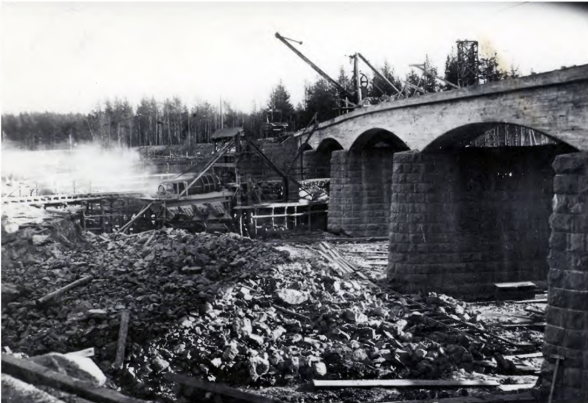
Kuva 9. Silta alkaa valmistua, kun kanavaa vielä kaivetaan ja rantamuureja rakennetaan. Kuva Paul Jyllinvuoren kokoelma, Imatran kaupunginmuseon kuva-arkisto.
