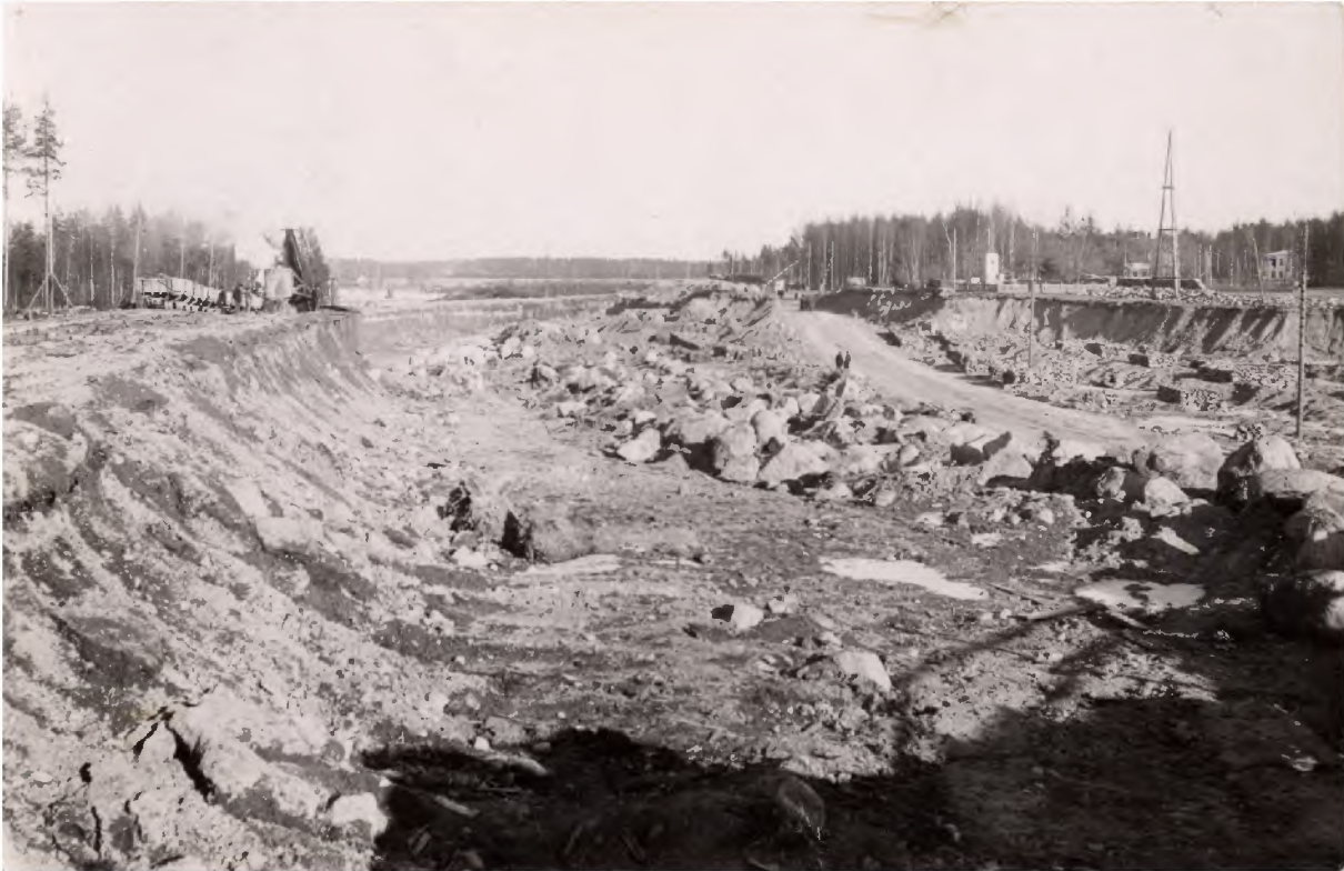
Kuva 4. Yläkanavaa kaivetaan 1920-luvulla. Kuvaaja Imatran valokuvaamo, Lappeenrannan museon kuvaarkisto.
