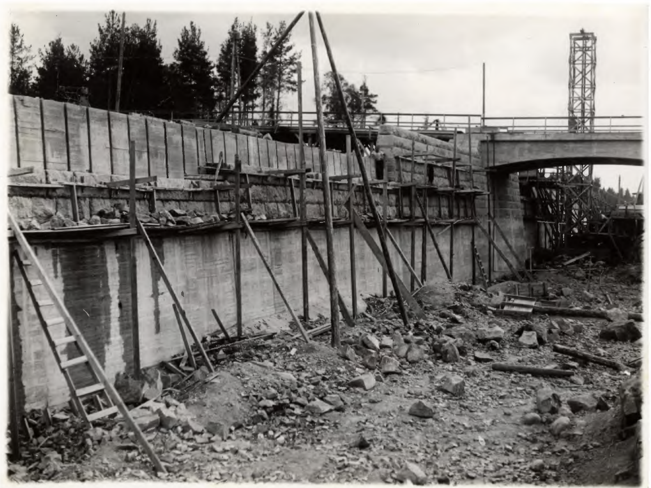
Kuva 8. Yläkanavan rantamuurien tekoa, kun silta on jo valmis. Kuva Walok. K W. Miettinen Wiipuri, Lappeenrannan museon kuva-arkisto.
