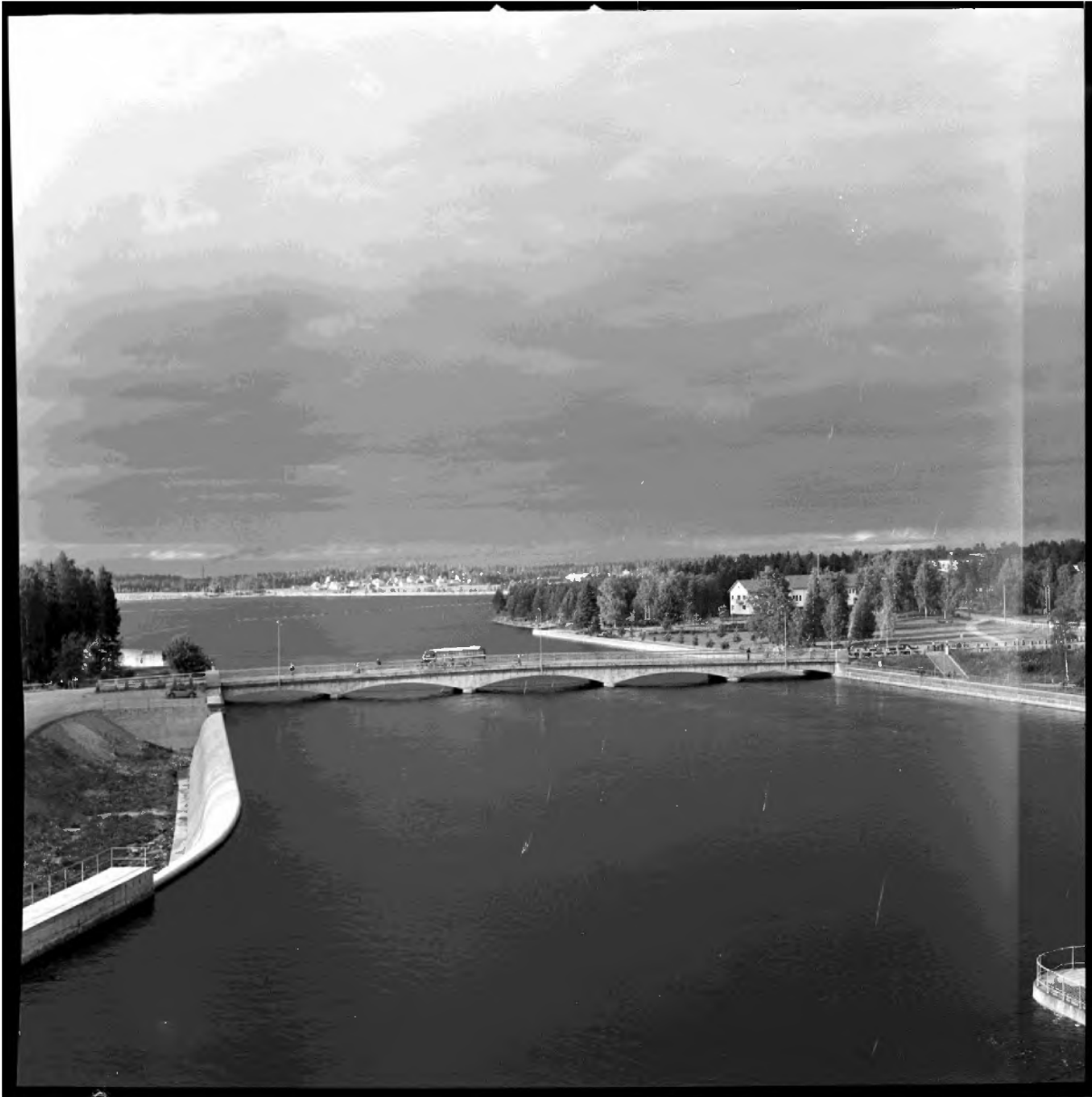
Kuva 14. Silta maisemassa vuonna 1955. Sillan molemmissa päissä kaiteet jatkuvat vaakaputkina, jotka on asennettu kivitolppien varaan. Kuvajaaja Kuvapaja, Lappeenrannan museon kuva-arkisto.
