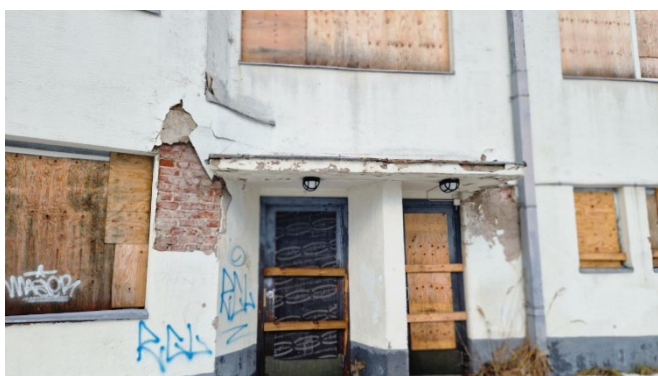
Kuva 7. Itäpuolen julkisivuvauriot.
