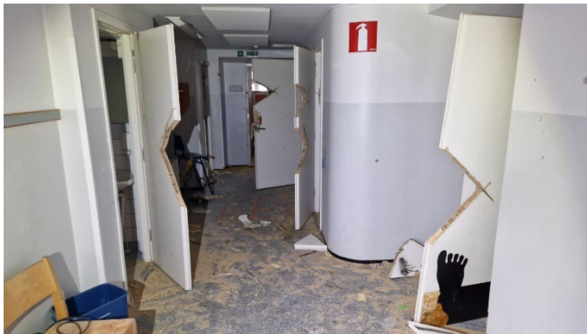
Kuva 9. Väliovien tilanne, kerrosten kaikki väliovet ovat rikkoontuneet viranomaisharjoituksissa.
