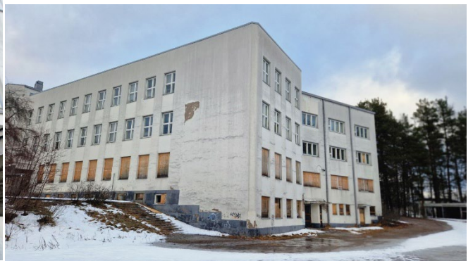
Kuva 6. Etelä-/itä puolen julkisivua.
