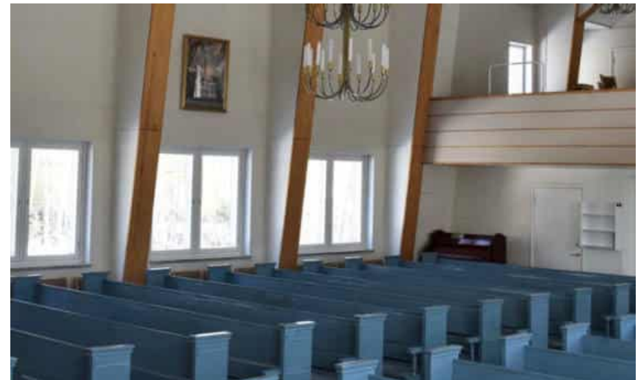
Kuva 2022: Ikkunoiden uusimisen yhteydessä muutettiin karmijakoa. Urkuparven kaide on alkuperäistä matalampi ja verhoiltu pellavalla; kuparilistat uusittiin koivulistoina.
