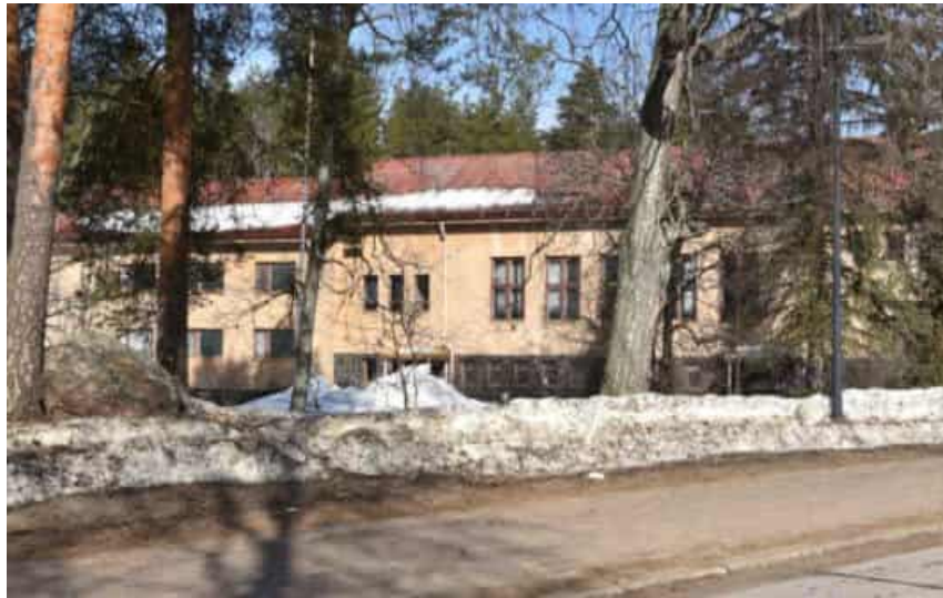
Kuva: Pitkä rakennusmassa jäsentyy asuntopuoleen ja kirkkopuoleen, kuten aikakauden koulurakennuksissa. Kanavakatuun rajautuvalla Kellotapulinmäellä on vanhaa puustoa.
