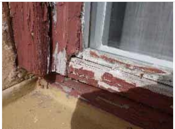
28. Eteläpuolen ikkuna ulkoapäin kuvattuna
