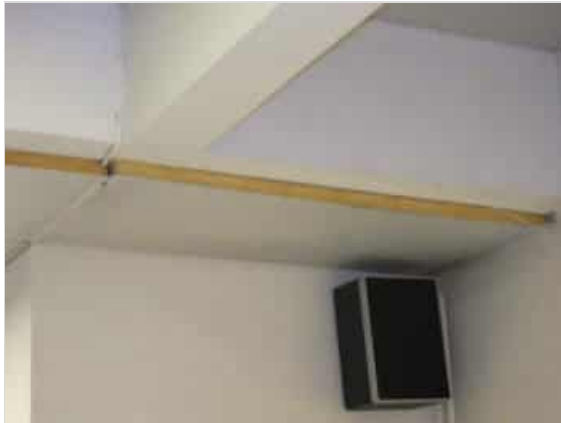
18. Avoin villapinta akustointilevyssä
