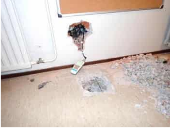
Rakenneavaus perusmuuriin
