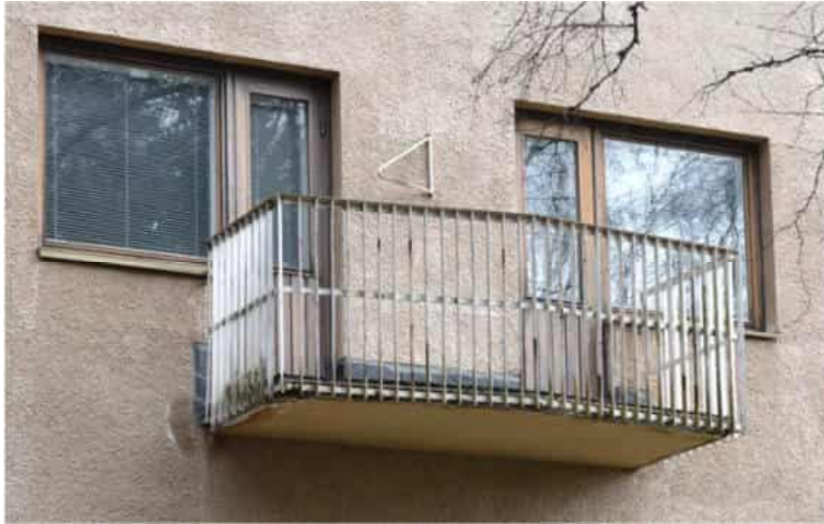
Kuva: Parveke. Asunnon ikkunat uusittu.
