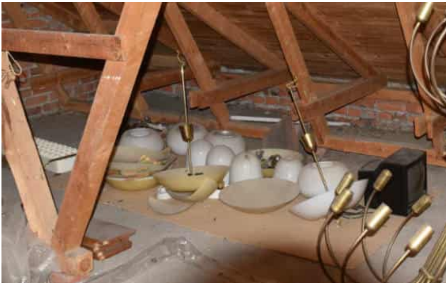
Kuva: Kattotuolin sidepuu lepää tiiliseinän päällä, jalasparrun ja vinotukien alla on tiilet. Palopermanto on betonia. Kuvassa on vanhoja opaalilamppuja.
