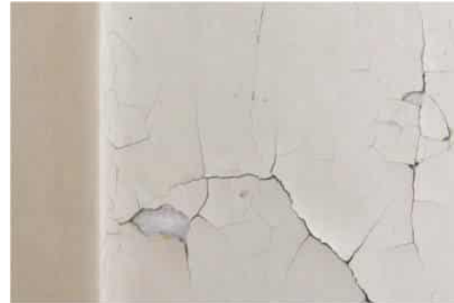
Kuva: Tiilimuuriseinässä on rappaus, tasoite ja maali.
