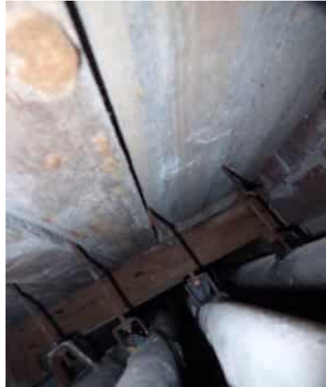
Näkymä kanaaliin, muottilaudat kanaalissa
