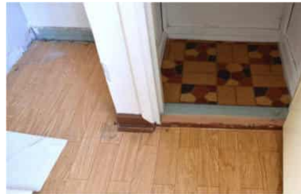
Kuva: Kiinteiden komerojen yhteydessä on säilynyt vanhoja listoja ja lattiapäällysteitä sekä lukkoja.
