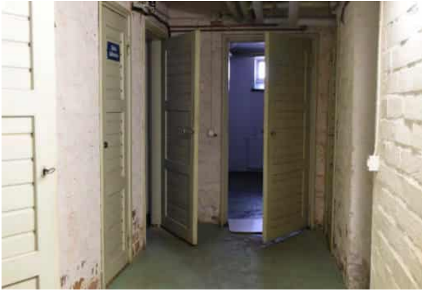
Kuva ylhäällä: Kellarikerroksen seinissä on tiiliverhous. Ovet ovat vaakalaudoitettuja kehysovia.
