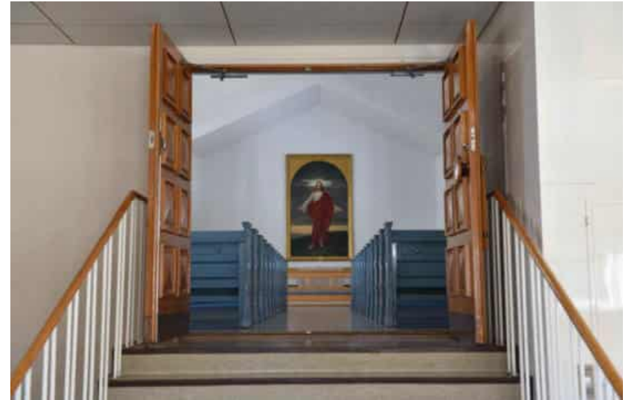
Kuva: Eteishallista kirkkosaliin nouseva porras ja jykevät puuovet. Sisäportaikkojen käiteet ovat samaa mallia, mutta kirkkosaliin porraskaiteessa on metallipinnoja hieman tiheämmässä kuin muissa portaikoissa, aina kaksi jokaisen askelman kohdalla.
