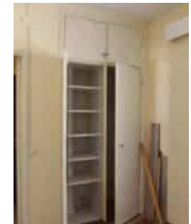
Kuva: Keittiökaapistot on uusittu. Vanhoja kiinteitä komeroita on edelleen jonkin verran jäljellä.
