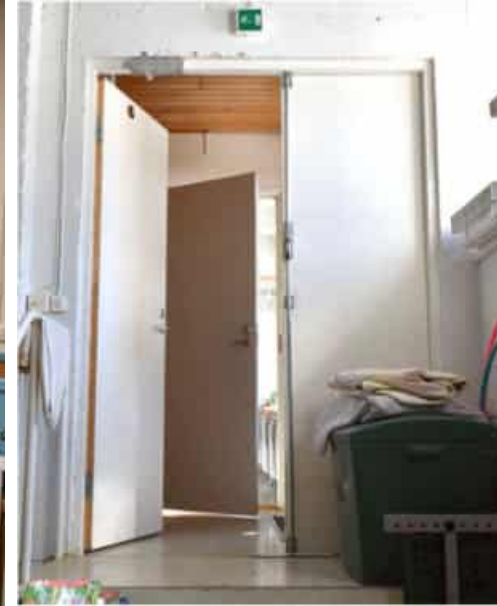
Kuva: Entistä kattilahuonetta.
