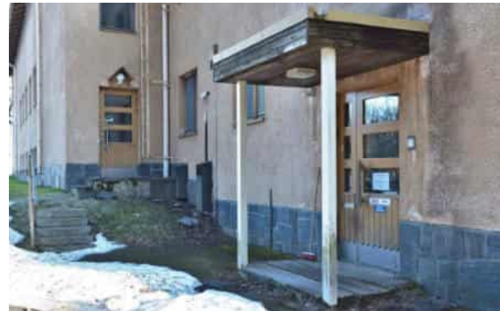
Kuva: Pohjoisen julkisivun vanhat sisäänkäynnit.
