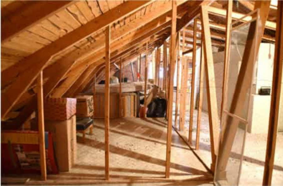
Kuva: Asunto puolen kattorakenne perustuu veisto- ja sahatavarasta tehtyihin konttikattotuoleihin, kitapuihin ja vinotukien kannattelemiin orsiin.
