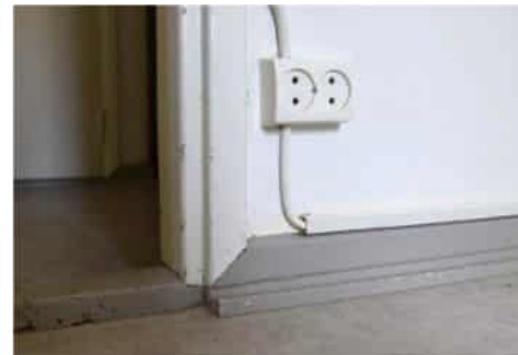
Kuva: Vanha lattialista, jossa syvennys mattolistalle. Puiet ovielistat ovat kapeita ja suoria.
