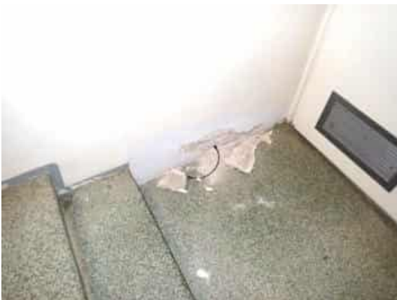
Kantavan väliseinän kosteusmittaus WC edestä
