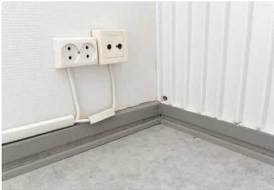
Kuva: Tavallisin seinäpinta on nykyään maalattu lasikuitutapetti. Rimoitettu levyseinä on ison asunnon ruokasalin ja olohuoneen välissä, mahdollisesti alkuperäinen.
