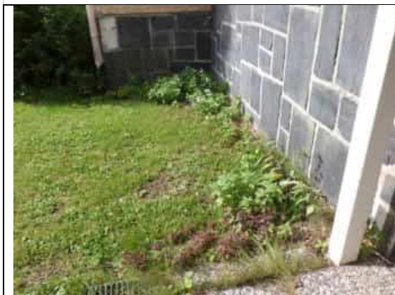
3. Nurmia-alueet ovat kiinni rakennuksessa
