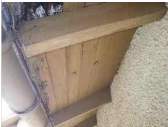
25. Lumiesteen kiinnitys läpi katteen
