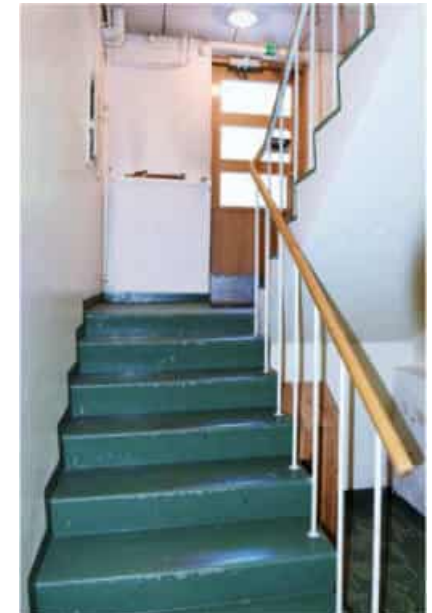
Kuva: Kirkkosalin porras: muovimatto ja lista. Kuva: Sivuportaan maalattu betonipinta.
