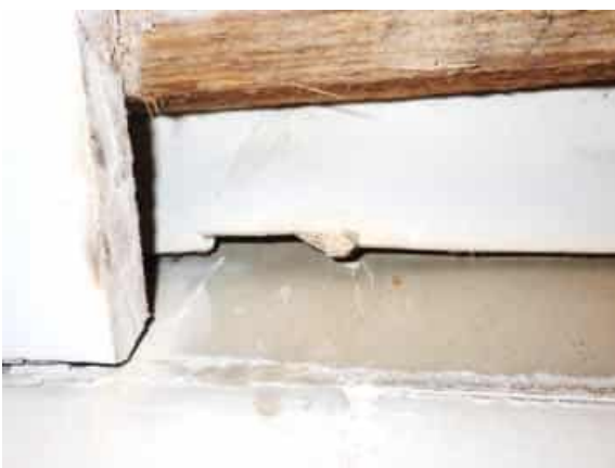
Lähikuva rakenneavauksesta, YP ilmansulkukartongkia ei ole liitetty US rakenteeseen mitenkään.
