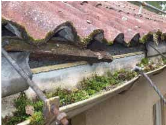
23. Räystäsrakenteen vaurioita
