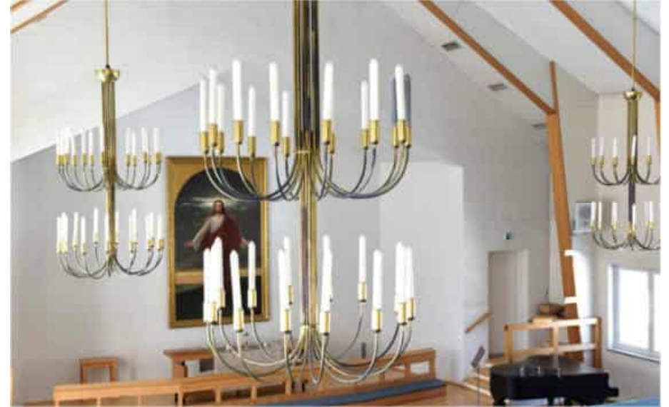
Kuva: Kirkkosalin kattokruunuihin on tullut patinoitumisen myötä sinertävää tummuutta.
