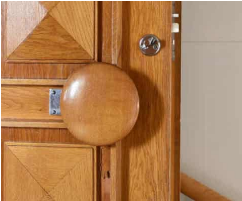
Kuva: Kirkkopuolen pääsisäänkäynnin ja varsinaisen kirkkosalin ovet ovat samanlaiset, raskaat ja koristeelliset. Niissä on pyöreä työntölevy ja puinen pitkävedin.
