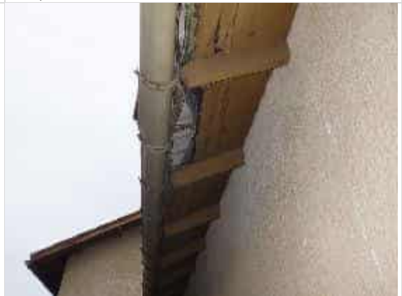
24. Räystäsrakenteen vaurioita
