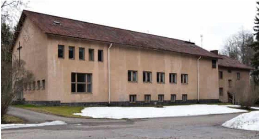
Kuva: Kirkkorakennuksen julkisivu takapihan suuntaan 2022.
