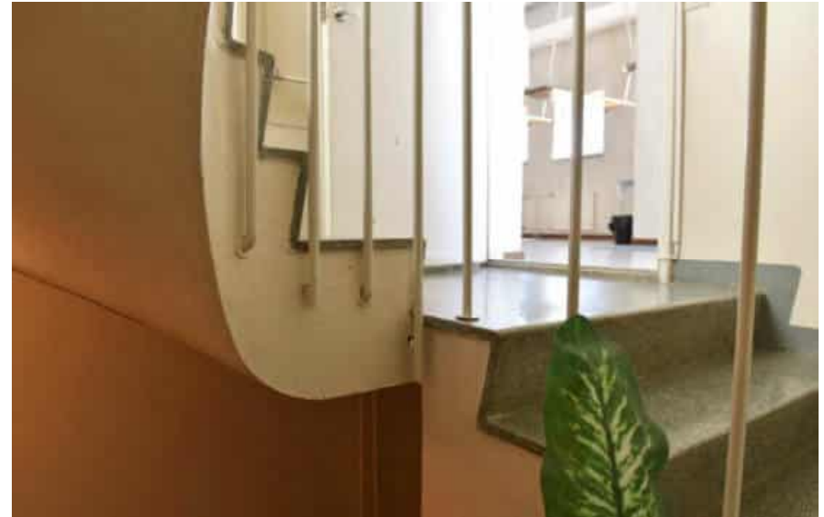
Kuva: Kirkkopuolen urkupalvelle nouseva porras. Sisäportaiden kaiteissa on kiiltävä puinen käsijohde ja peittomaalattu metallipinnakaide. Pinnat nousevat joko askelmalta tai portaan sivusta.
