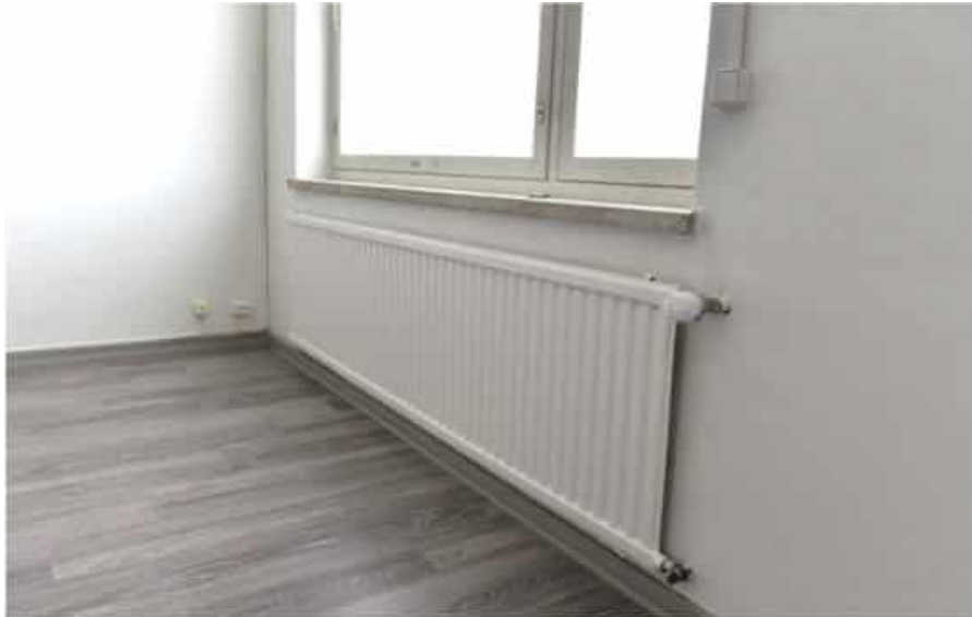
Kuva: Ikkunat on uusittu. Ikkunapenkki on mosaiikkibetonia. Lattiassa on laminaatti ja 1980-luvun patteri PURMO-mallista.
