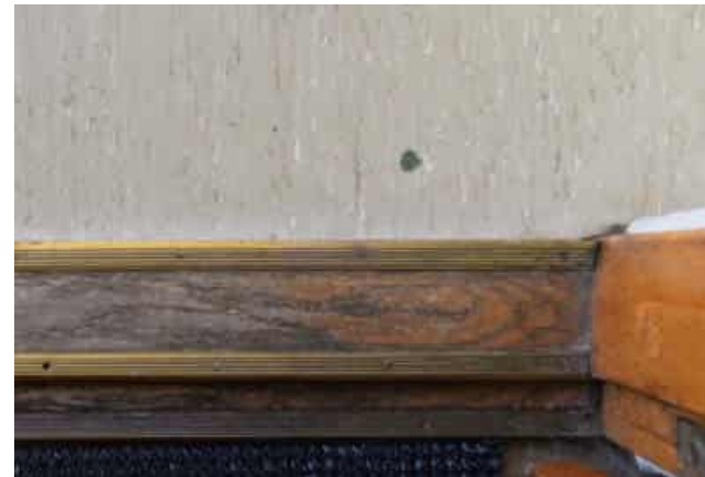
Kuva: Eteishallin muovimatto, puukynnys metallilistoin. Ovenkarmissa keskitaite.
