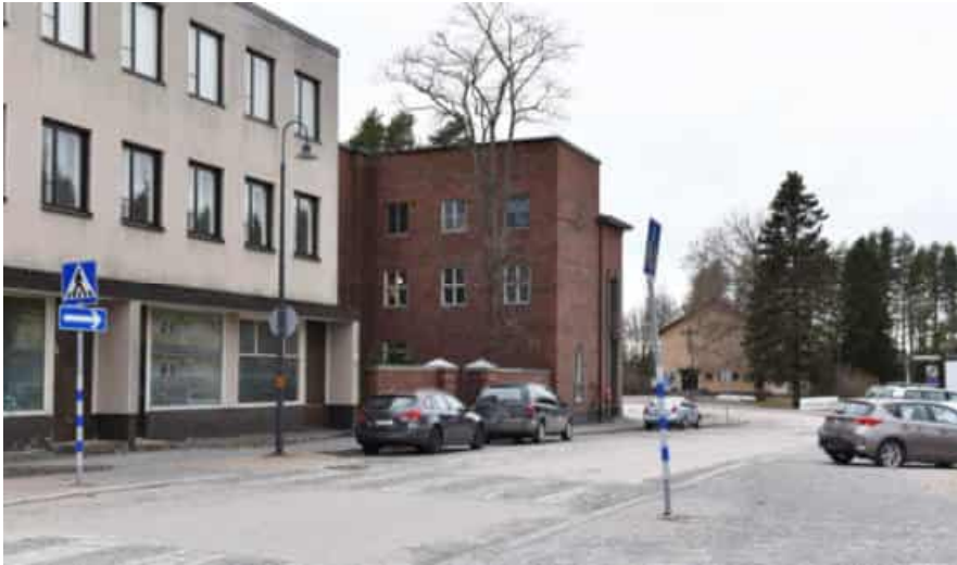
Kuva: Kirkkorakennus on katunäkymän päätteessä idästä lähestyttäessä. Entisen asema-aukion ja kirkon välillä säilyneet 30-luvun liiketalot muodostavat yhtenäistä katutilaa. Kanavakatu 5:ssä on 1932 valmistunut punatiilinen PYP:n Imatran toimitalo (Uno Ullberg), myöh. apukoulu ja työväenopisto sekä yritystalo. Etualalla oleva Kanavakatu 7 on myös 1930-luvun kivitaloja (Anttikosken kauppa).
