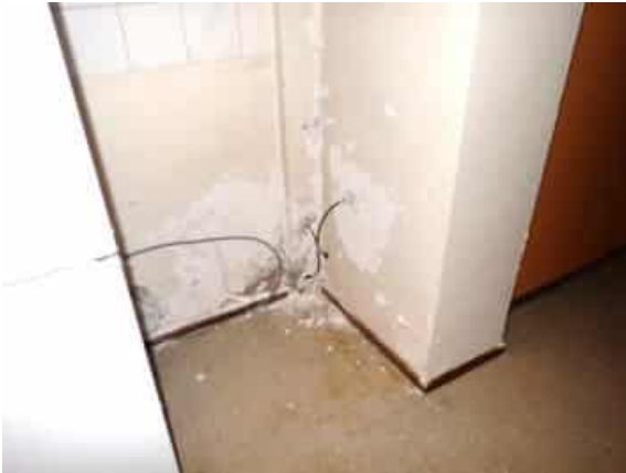
Kantavan väliseinän kosteusmittaus keittiö
