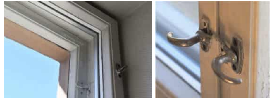
Kuvat: Vanhat lisälasilla varustetut sisäänaukeavat ikkunat. Kulmaraudat ovat ulkopuitteiden sisäpuolella. Vanhoissa puitteissa on alkuperäistä heloitusta: kääntösulkimet ja vastakoukku.
