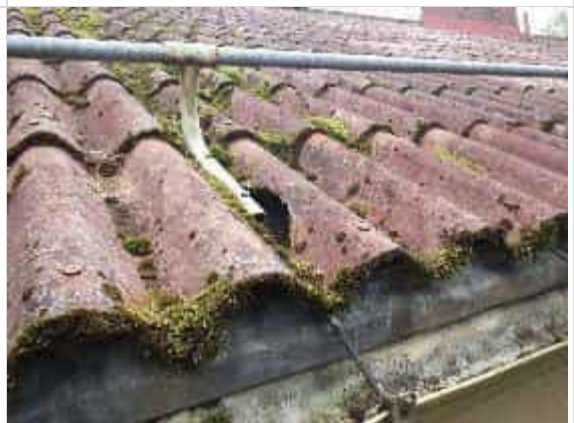
26. Lumieste vesikaton puolella
