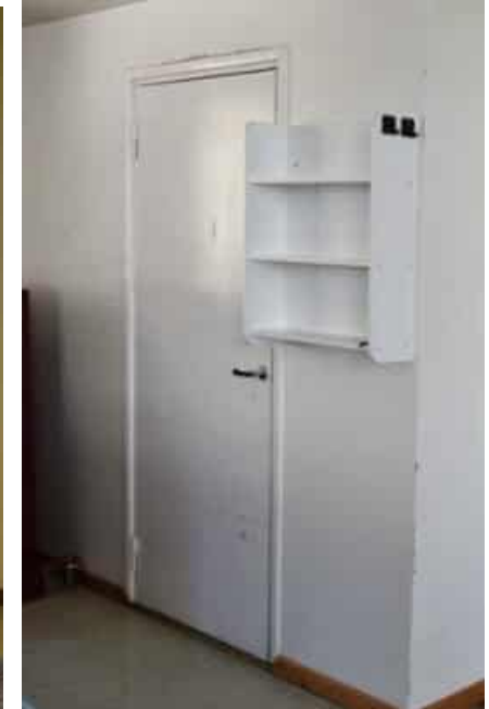
Kuva: Maalattu laakaovi.
