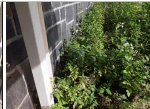
4. Kasvillisuutta rakennuksen vierustoilla
