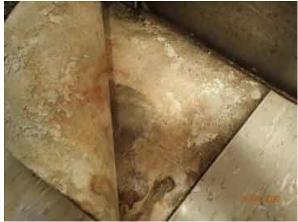
Kosteusvaurioitunut muovimattopinnoite
