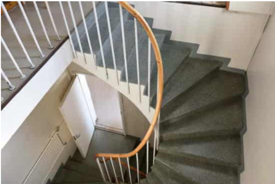
Kuva: Urkuparvelle nousevat kierreporras, alhaalla näkyy eteishalliin auki oleva ovi. Metallipinnat on kiinnitetty betoniaskelman sivuun,
