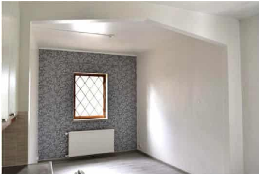
Kuva: Kappalaisen asuinhuoneiston työhuoneeksi suunnitellussa tilassa on juhllaisuutta tuova kolminivelkehä sekä vinoneliöruutuinen tammipuinen ikkuna.
