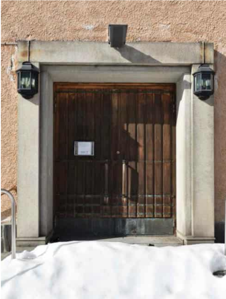
Kuva: Kirkon pääoveen on saatu juhllaisuutta hakattupintaisella kiviportaalla ja -portaalla.
