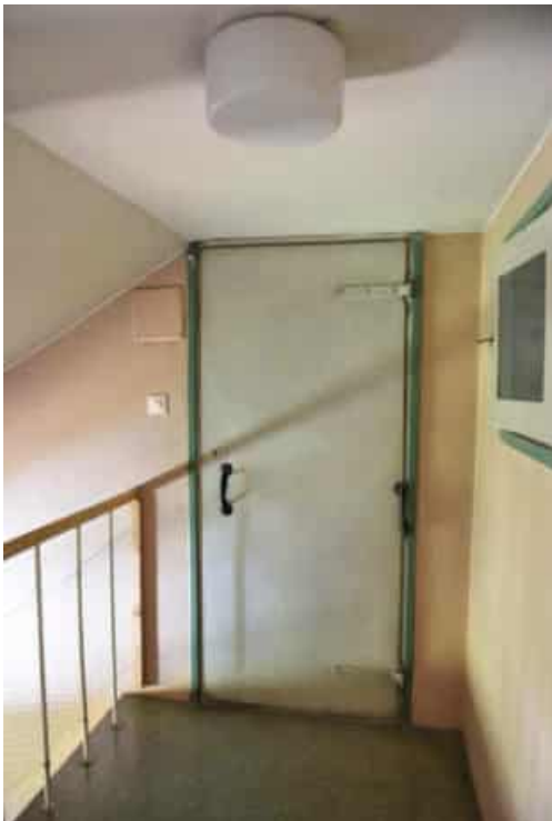
Kuva ylhäällä: Kellarikerroksen seinissä on tiiliverhous. Ovet ovat vaakalaudoitettuja kehysovia.
