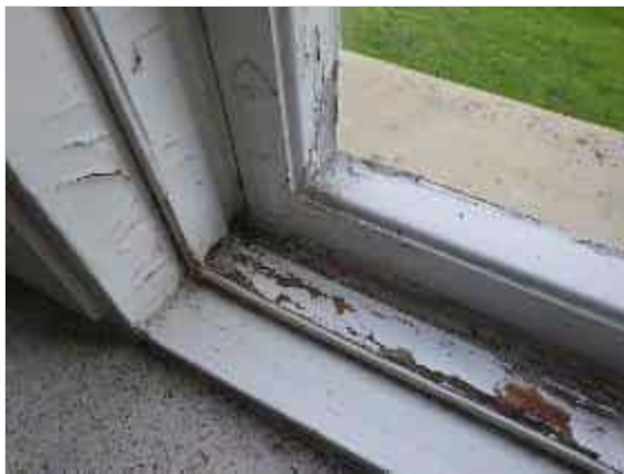
27. Pohjoispuolen ikkuna sisältäpäin kuvattuna
