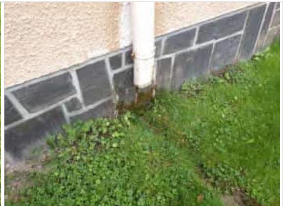
2. Sadevesikouru valuttaa vedet perusmuurirakenteelle
