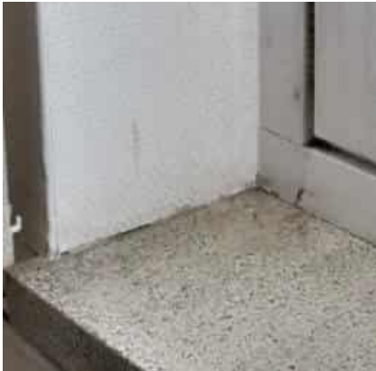
Kuva vasemmalla: Lasikuitutapettia ikkunan smyygissä. Ikkunapenkki mosaiikkibetonia.
