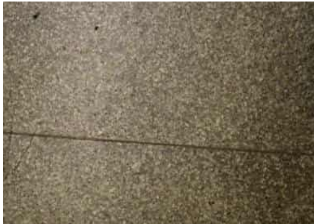
Kuva: Mosaiikkibetonilattia metallisilla saumalistoilla entisessä vaatevarastossa urkuparvelle nousevan portaikon pohjakerroksessa.
