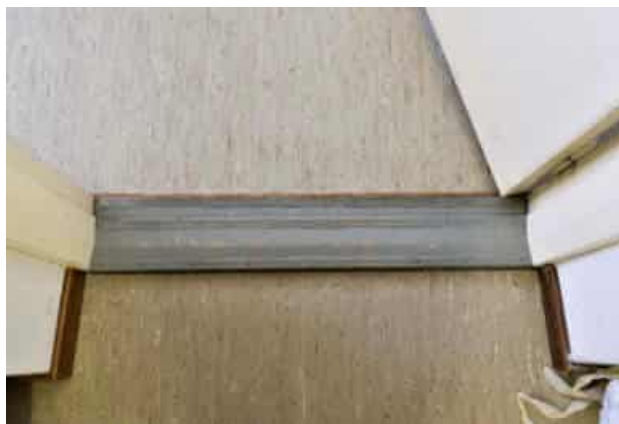
Kuva: Kirkkosalin ja peräseinän komeron muovimatot ja suorat matalat lattialistat. Ovenkarmissa keskitaite.
