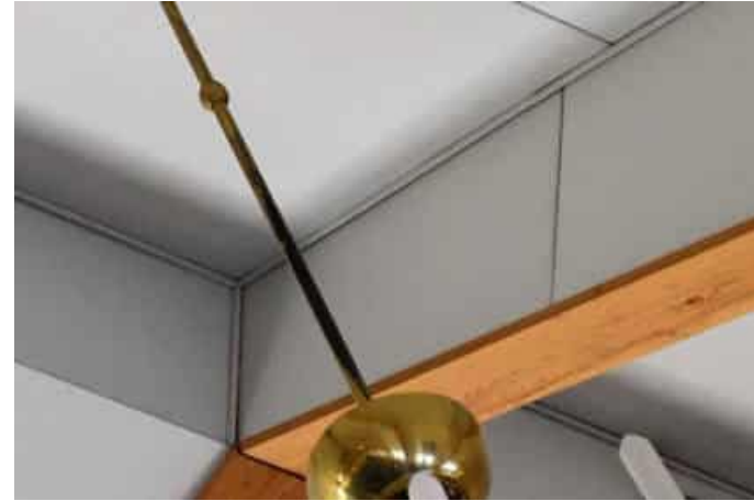
Kuva: Kirkkosalin katon ja kehien 80-luvulla uusittua levyverhousta. Kehät oli alun pitäenkin levytetty, mutta mäntypuinen lista on lisätty 1980-luvun peruskorjauksessa.
