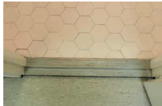
Kuva: Märkätilassa Pukkilan kuusikulmaisia laattoja. Maalattu puukynnys metallilistoin. Ovenkarmissa keskitaite.
