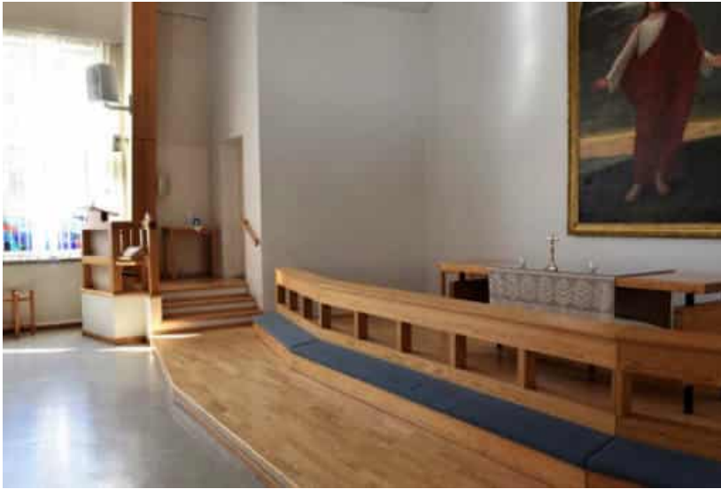
Kuva 2022: Alttarikoroketta on madallettu ja tehty sivuportaat entisellä tasolla oleville sivuoville ja uudelle saarnastuolille. Alttarikaide ja -pöytä on tehty mäntypuusta, kaide niveltämällä kaarevaksi. Kuorin sakastinpuoleiselta sivuseinältä on poistettu ovi.
