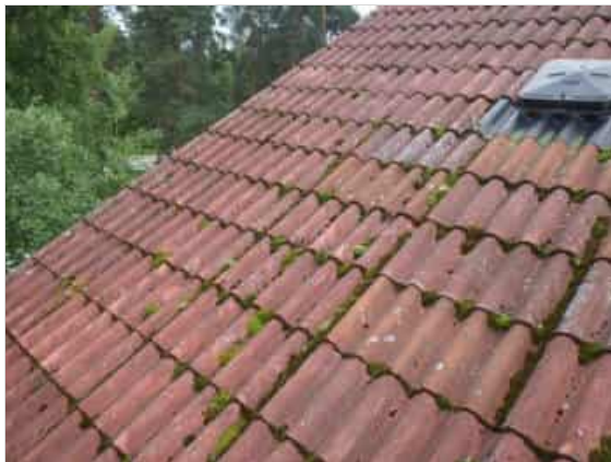
19. Yleisnäkymä vesikatolle, sammalta pinnalla
