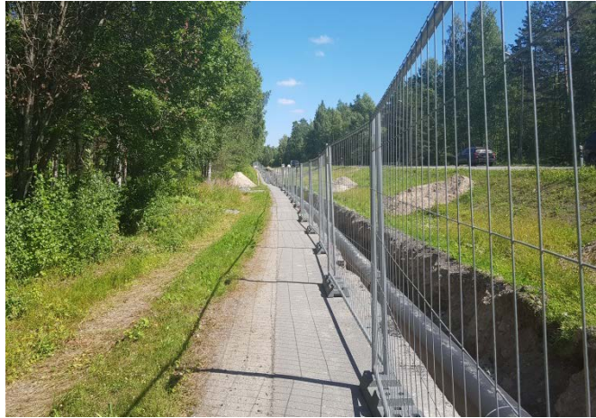
Keskuskadun runkolinjan rakennusta
