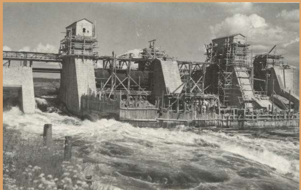
Imatran voimalaitoksen ja padon rakennustyöt vuonna 1928. Kuva: Työväen arkisto.
