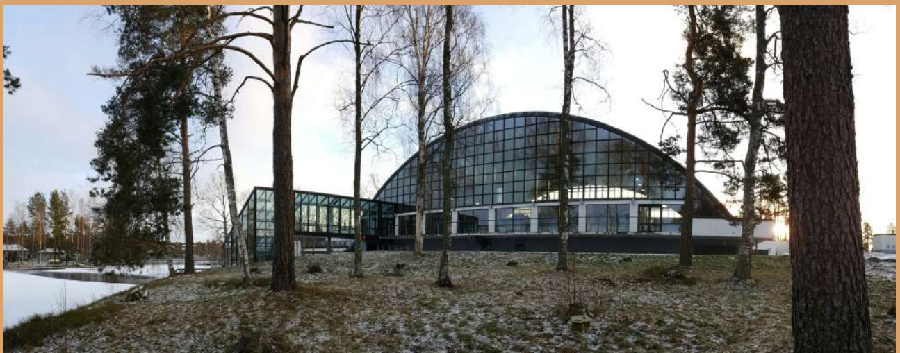
Uimahallin sisäkaton voimakasa kaareva muoto toimii hyvin kontrastina sisä- ja ulkotilojen suurille ja yhtenäisille lasipinnoille. Kuvat: Imatran kaupunki.
