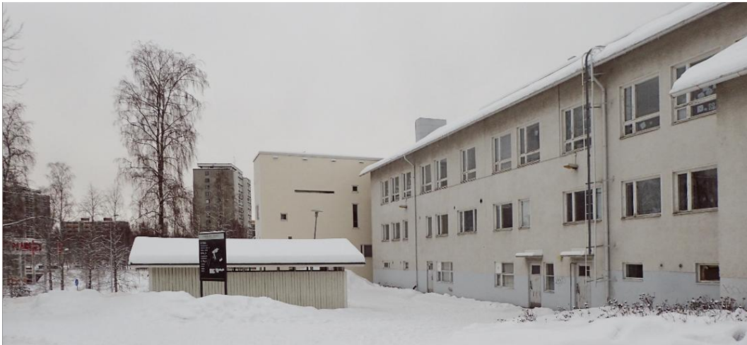
Kuva 2. Linnalan koulurakennus tammikuussa 2019. (©Rejlers Finland Oy)
