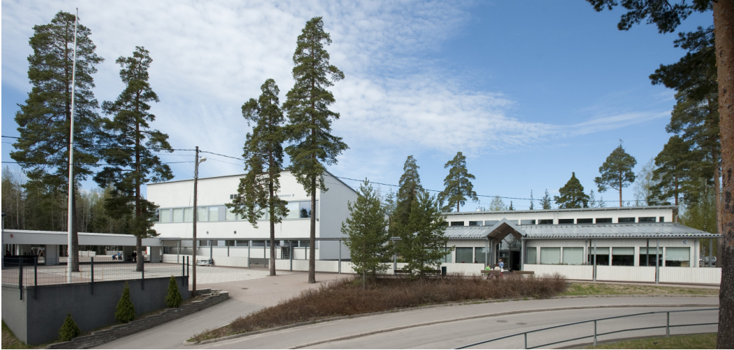
Vuoksenniskan koulukeskuksen vanha puoli.
