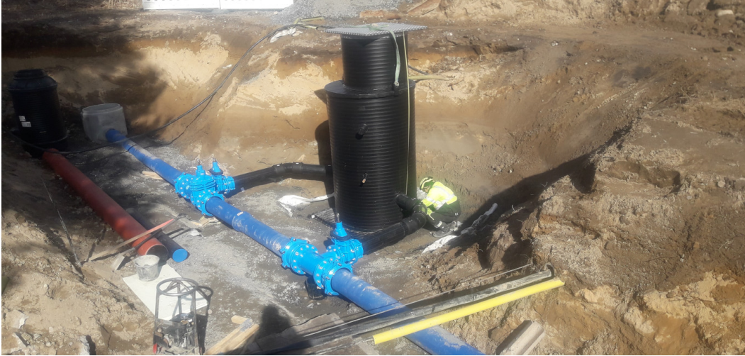
Vesiputkea Myllypuron linjan työmaalta.
