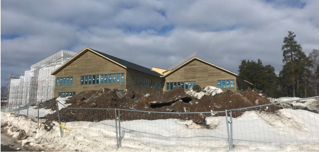
Mansikkalan koulukeskustyömaa kuvattuna 24.3.
