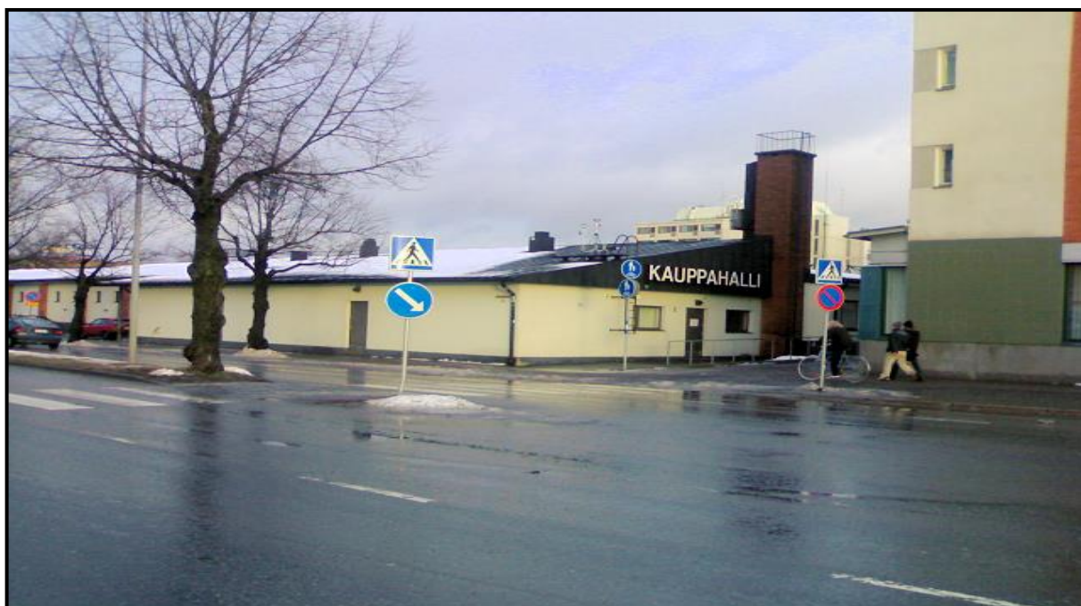
Kuva 13: Lappeenrannan keskustan mittausasema sijaitsee Snellmaninkadun varrella olevan Kauppahallin tiloissa.
