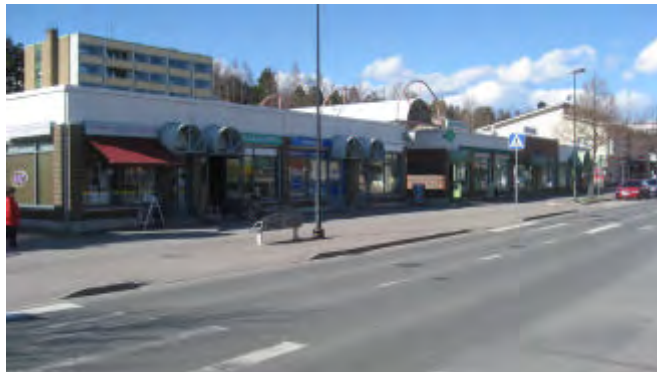
Vuoksenniskan liikerakennukset kaipaavat pientä kunnostusta julkisivuihin, jotta kaupallinen ilme vahvistuisi
