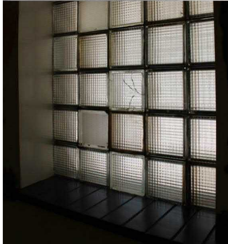
Oppilaskäytävän alkuperäiset lasitiili-ikkunat.
