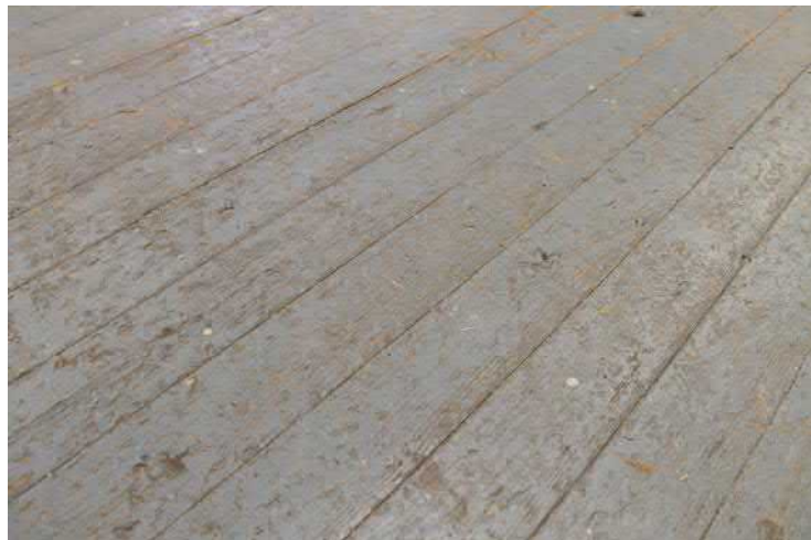
Puutyöluokan alkuperäinen puulattia.
