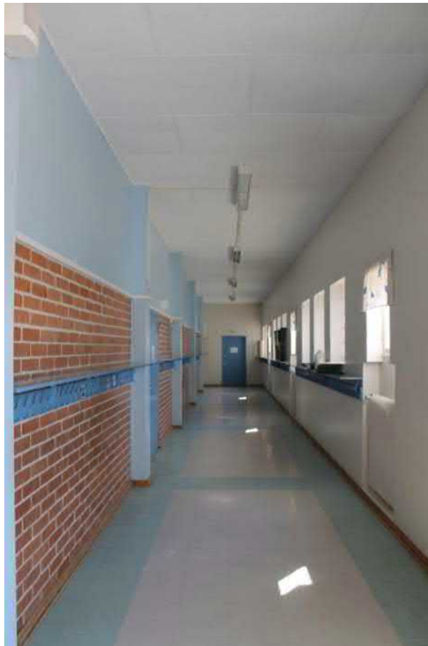
Alhaalla oikealla kouluosan ja asunto-osan välille puhkaistiin kulkuyhteys vuonna 1979.
