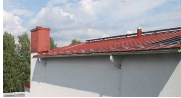
Vuonna 1991 uusittiin peltikatto. Syöksytorvet ovat alkuperäiset.
