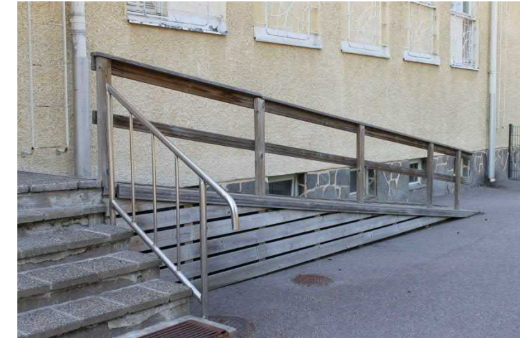
Päiväkodin luiska rakennettiin vuonna 2000.
