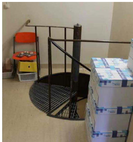
Vuonna 1976 puhkaistu kulkuyhteys kellarikerroksen ja I-kerroksen välille.
