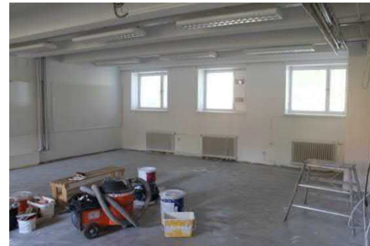
Pohjakerroksen luokkahuonetta remontoitiin parhaillaan.
