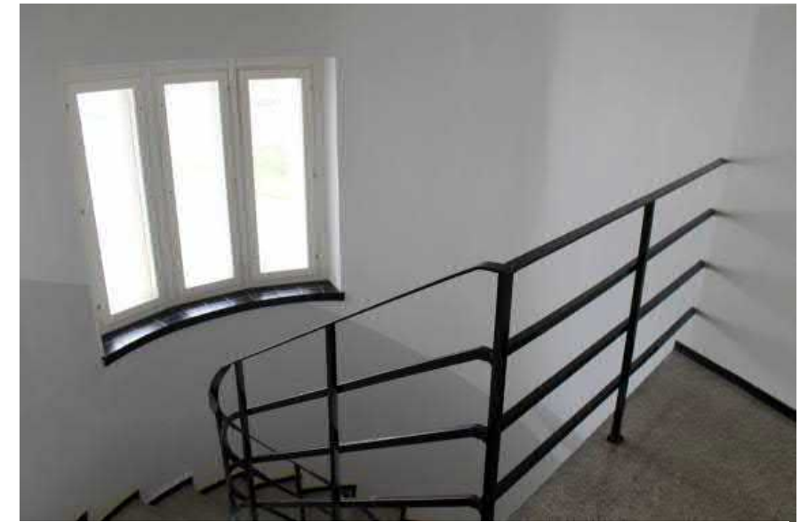
Kouluosan ja asunto-osan välinen porrashuone. Ikkunalaudat on päällystetty keramiikkalaatoilla.
