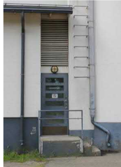
Vuonna 1992 tehty sisäänkäynti. Palotikkaat on elegantin pelkistetyt. Jokainen askelma on yksittäin julkisivuun kiinnitettyä teräsputkea.
