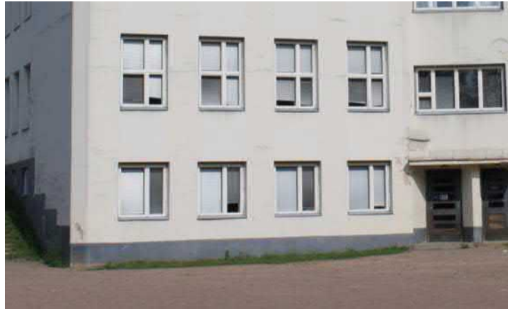
Pohjakerroksen puutyöluokan ikkunat poikkeavat muista ikkunoista.
