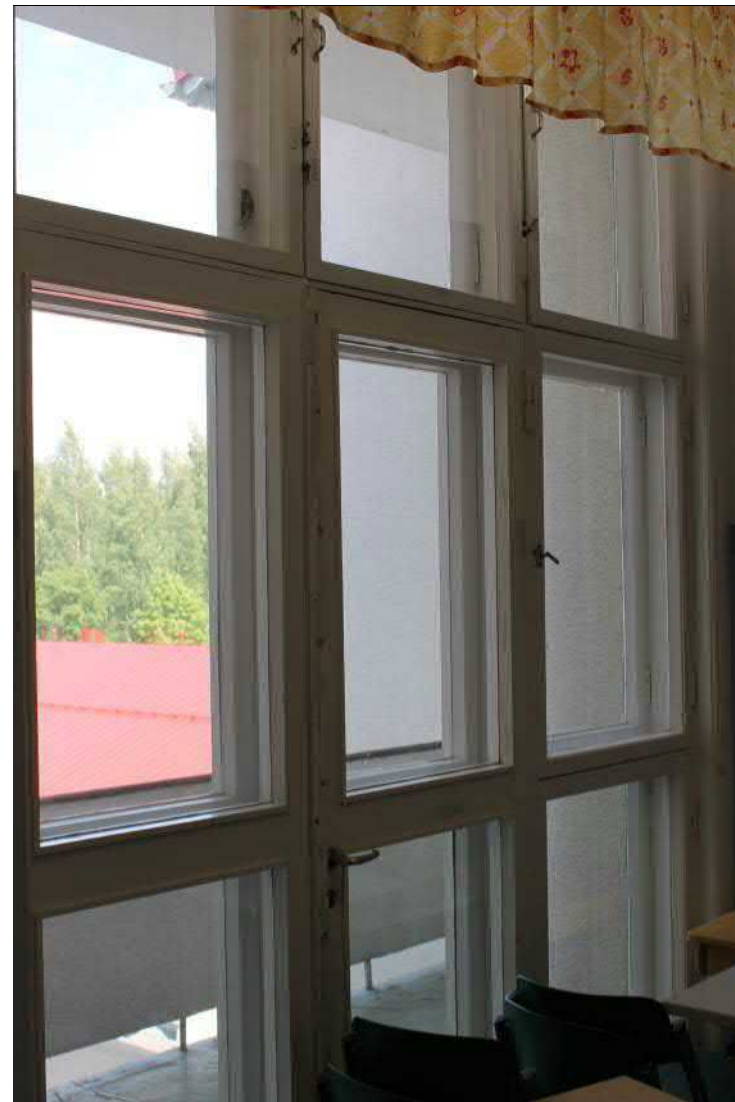
Sisäpihan parvekkeiden alkuperäiset ikkunat kolmannessa kerroksessa.
