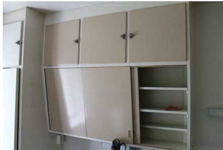
Alkuperäisiä vaneri-ovisia keittiökallusteita asunto-osassa.
