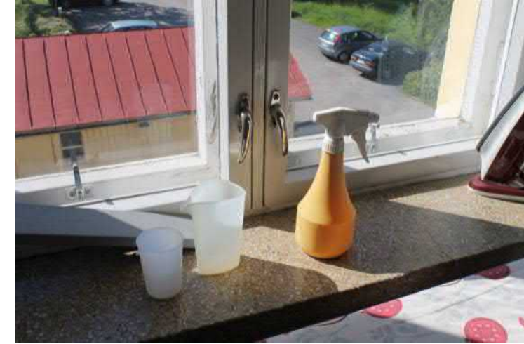
Rakennuksen alkuperäiset mosaiikkibetoniset ikkunalaudat.
