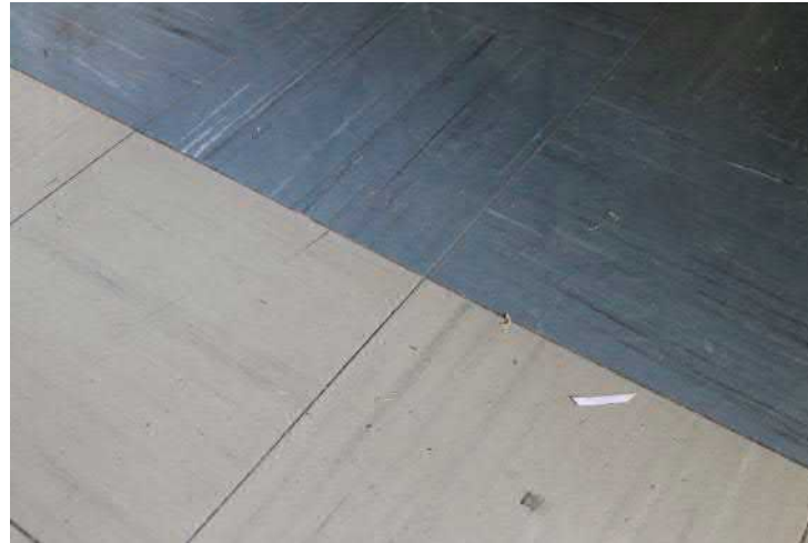
Kouluosan aula-tilojen lattiamateriaalina on Hovi-laattaa.
