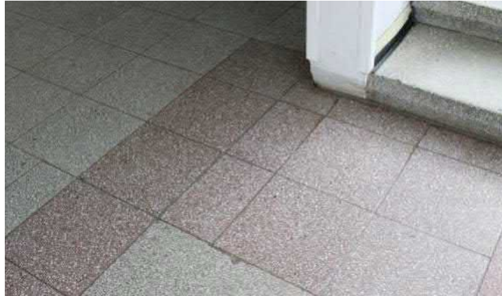
Käytävätiloissa on käytetty punertavaa ja harmaata mosaiikkibetonilaattaa.
