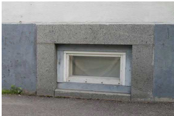
Kellarikerroksen ikkunoita reunustaa graniittiset reunakivet.
