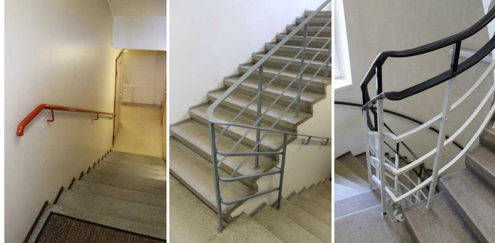
Vasemmalla C-portaan punaiseksi maalattu metallikaide, keskellä B-portaan harmaa metallikaide ja oikealla D-portaan musta-vaikoinen kaide.
