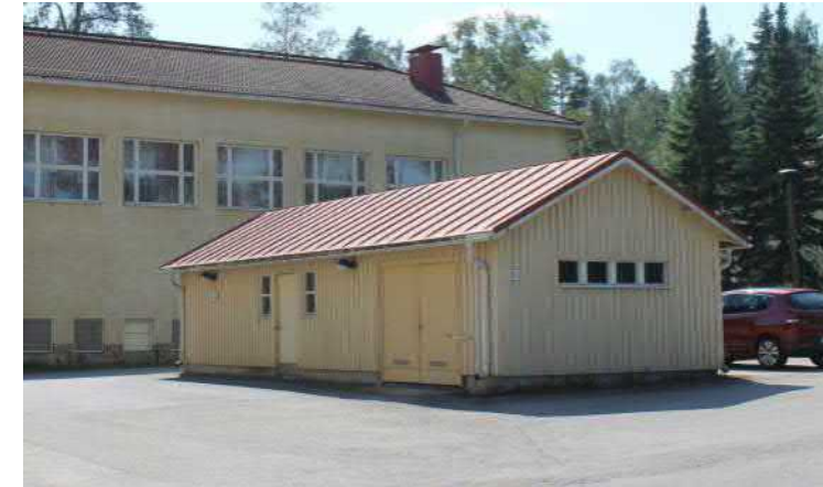
Varaston julkisivumateriaalina on keltainen pystypeiterimoitus.
