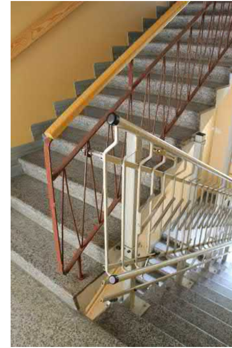
Kouluosan takapihan puoleinen porrashuone.
