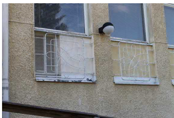
Osa juhlasalin ja kouluosan ikkunoista on suojattu verkolla.
