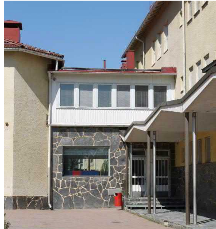
Luokkahuone rakennettiin sisääntulon yläpuolelle. Sen julkisivumateriaalina on valkoinen pystylautaa.
