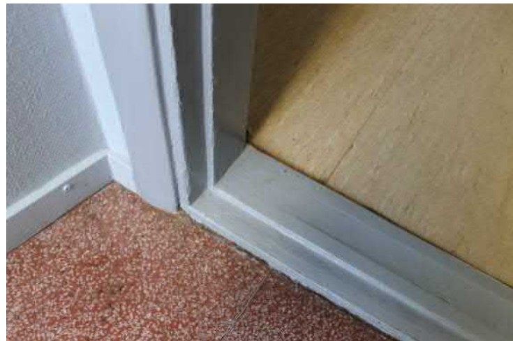
Alkuperäiset mosaiikkibetonilattia sekä oven karmit.
