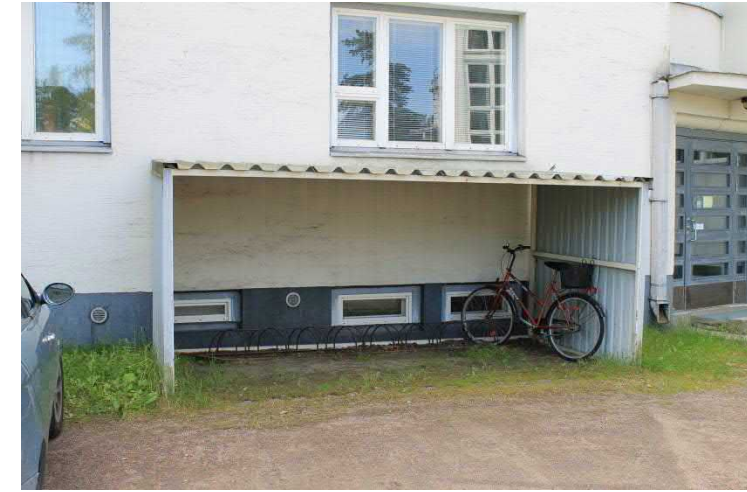
Kevytrakenteinen pyöräkatos sisäpihan puolella.
