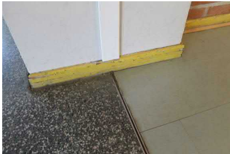
Aulatilän ja oppilaskäytävän liitoskohta.
