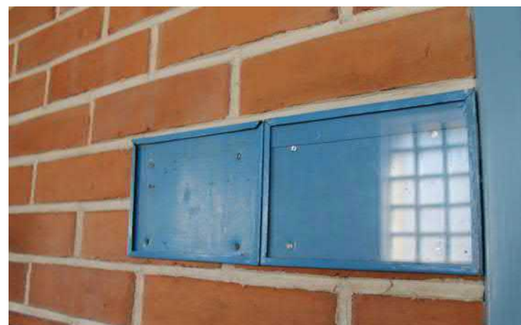
Luokkahuoneiden ovien vieressä on metalliset taulut.
