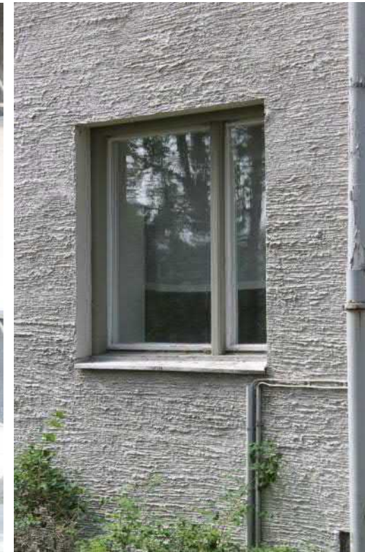
Asunto-osassa on alkuperäiset ikkunat.
