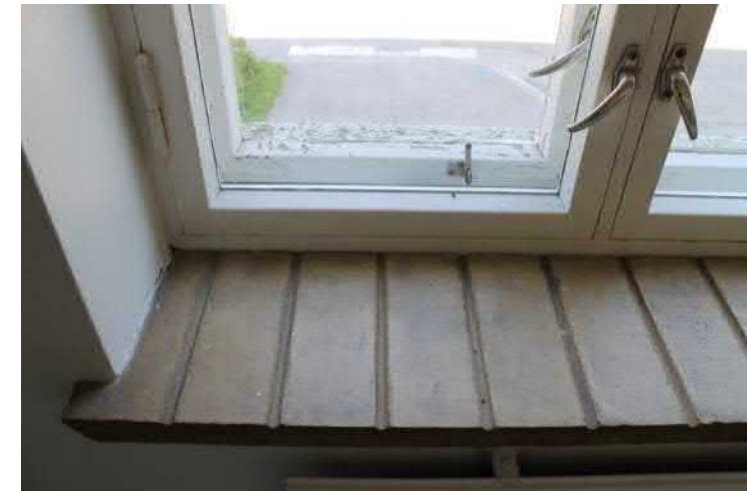
Tiiliset ikkunalaudat asunto-osassa.
