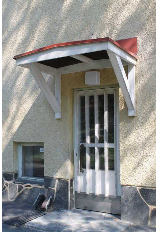
Esikoulun sisäänkäynti juhlasaliosan Länsipäädystä. Puurakenteinen katos on Lisätty sisäänkäyntiä suojaamaan jälkepäin.
