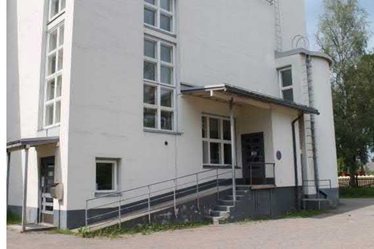
Luiska kaiteineen rakennettiin vuonna 1992.
