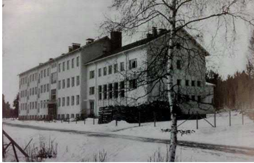
Koulurakennus valmistui lopullisesti vuoden 1953 lopulla. (Imatrankosken koulu 50 vuotta)
