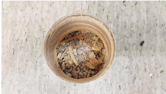
Kuva 10. Puurakenteisen lattian täyttö
