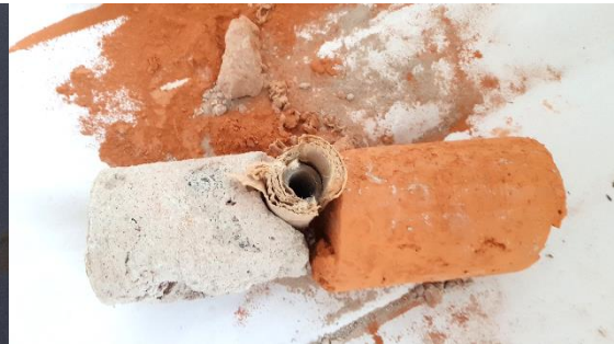
Kuva 14. Rakennekerrokset seinästä. Lämpöjohton päällä on rappauserros
