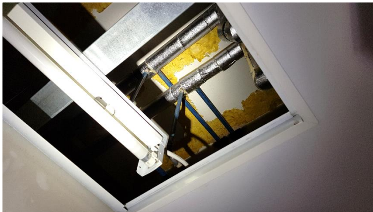
Kuva 23. Vanhat akustovillojen jäänteet alaslaskukaton yläpuolella
