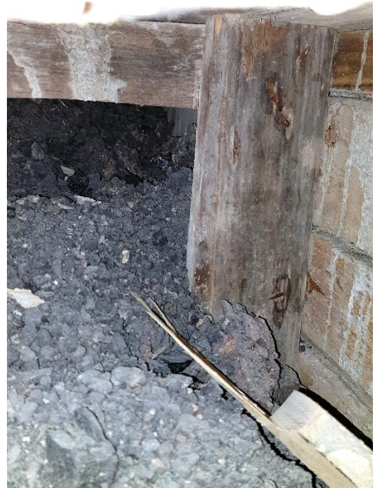
Kuva 8. Näkymä lattiarakenteen alapuolelle (ruokala)
