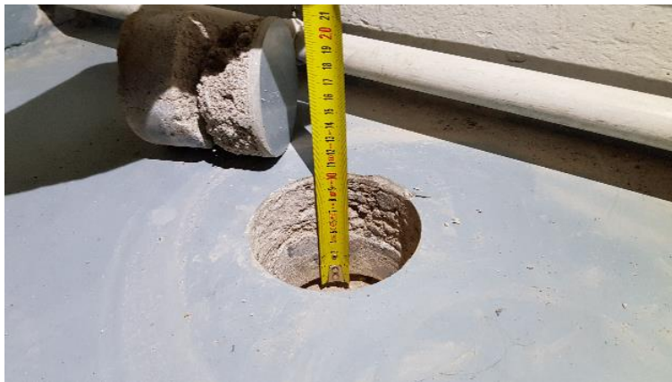
Kuva 1. Kellarikerroksen maanvastainen betonilaatta, paksuus 100 mm.
