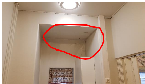
Kuvat 21 ja 22. Alue kabinetin seinässä, jossa kosteuspoikkeama.
