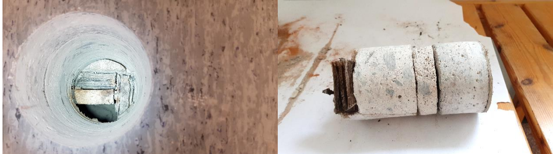
Kuvat 4 ja 5. Luokan 1 (132) välipohjarakenteen avaus. Muottilauδοitus on jätetty rakenteeseen
