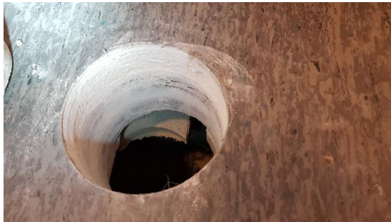
Kuva 7. Näkyvää lattiavalun muottilauδοitusta
