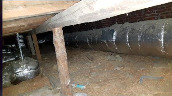
Kuva 17. Yläpohjan purueristys ja vesikaton vanhat puurakenteet
