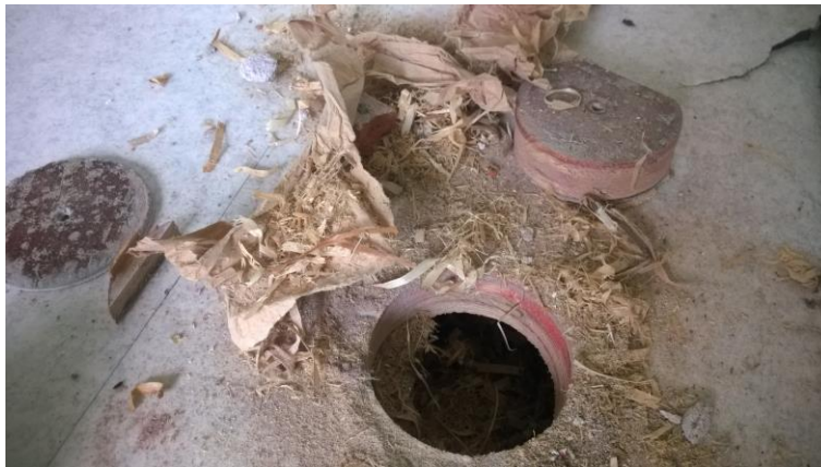
Kuva 1. Rakenneavaus keittiönlattiasta
