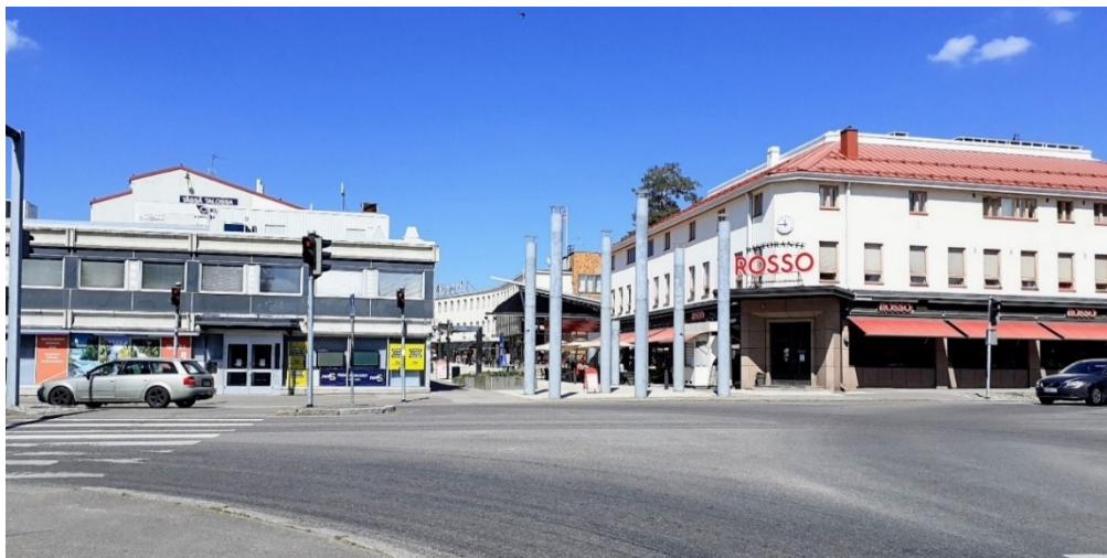
Kuva 1. Suunnittelualue sijaitsee kaupunkikuvallisesti keskeisellä paikalla ja merkitsee Koskenpartaan kävelykadun alkupään. (Kuva: Imatran kaupunki)
