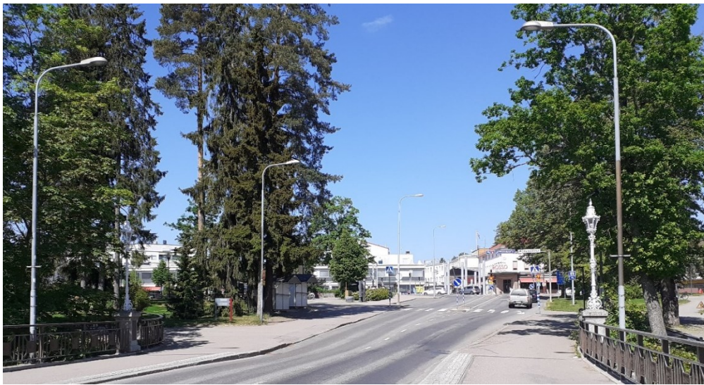
Kuva 5. Suunnittelualue on kaupunkirakenteessa keskeisellä paikalla ja antaa ensivaikutelman keskusta-alueesta Imatrankoskentieltä saavuttaessa. (Kuva: Imatran kaupunki)
