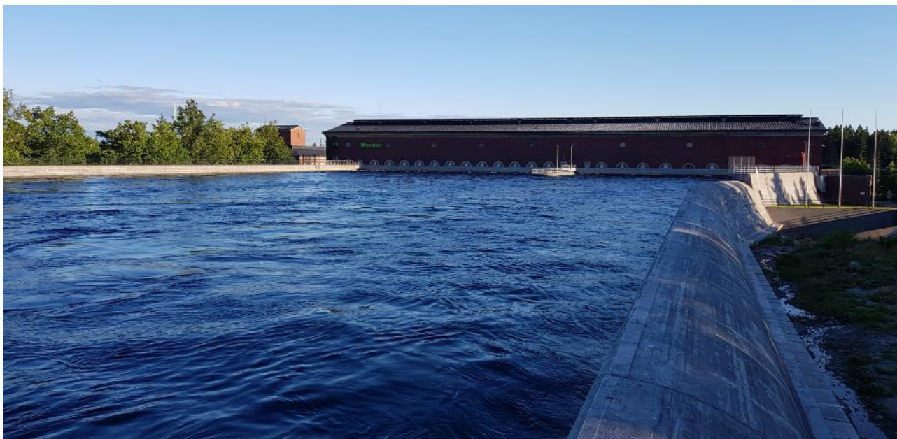
Kuva 5.22. Fortumin Imatran voimalaitos. (Kuva: Broman, 2020)
