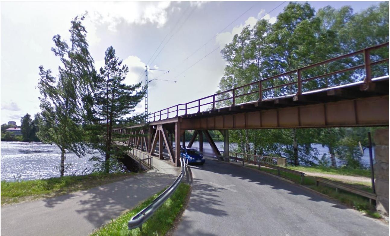
Kuva 8.5. Imatra-Luumäki-ratahankkeen myötä Vuoksen ylittävä Mansikkakosken vanha ratasilta on kunnostettu ja poistunut rautatieliikenteen käytöstä. Korvaava uusi kahden raiteen ratasilta on rakennettu nykyisen sillan pohjoispuolelle. (Väylävirasto, Luumäki–Imatra-ratahanke.) Kuva: GoogleMaps.
