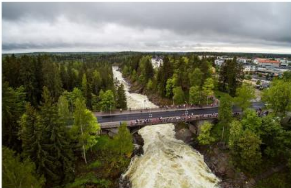
Imatrankosken silta (Kuva: Imatran kaupungin kuvapankki)
